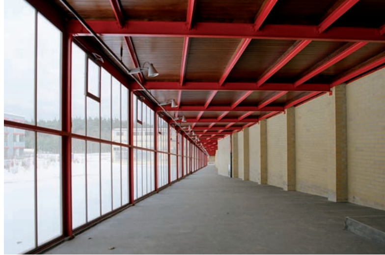
7. Glass corridor after restoration, 2007. BRENNE Gesellschaft von Architekten mbH, Berlin
