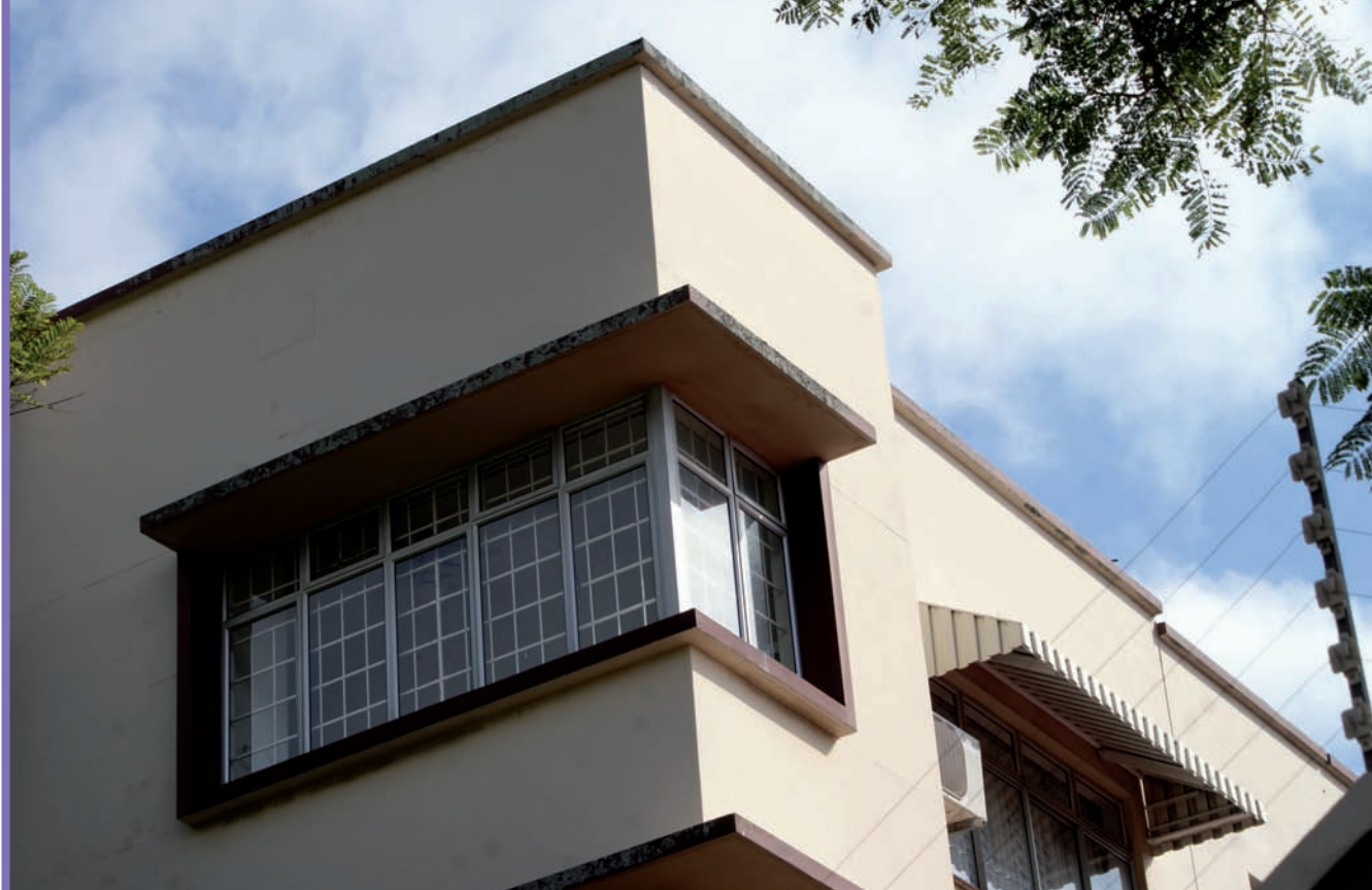
7. Motyw otaczający okno narożne w budynku Dronfield (553 Che Guevara Rd, 1942 r.). Opaska tynkowa obejmuje dwa brzozy fasady i wysunięte nadproża okien. Wbudowane w późniejszym okresie aluminiowe ramy okienne jedynie dotykają się krawędziami
