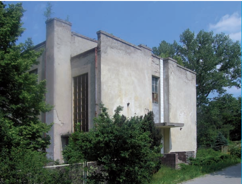
7. Budynek Szkoły Mechanicznej w Skarżysku, arch. R. Kalinowski, ok. 1938 (fot. M. Furtak)
