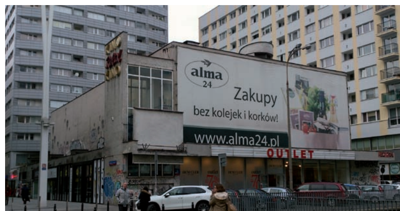
7. Dawne kino „Relax” przy ul. Złotej w Warszawie, proj. Z. Waclawek, Z. Gąsior, 1969 (fot. M. Czarnecki, 2015). Obiekt został przeznaczony do wyburzenia
