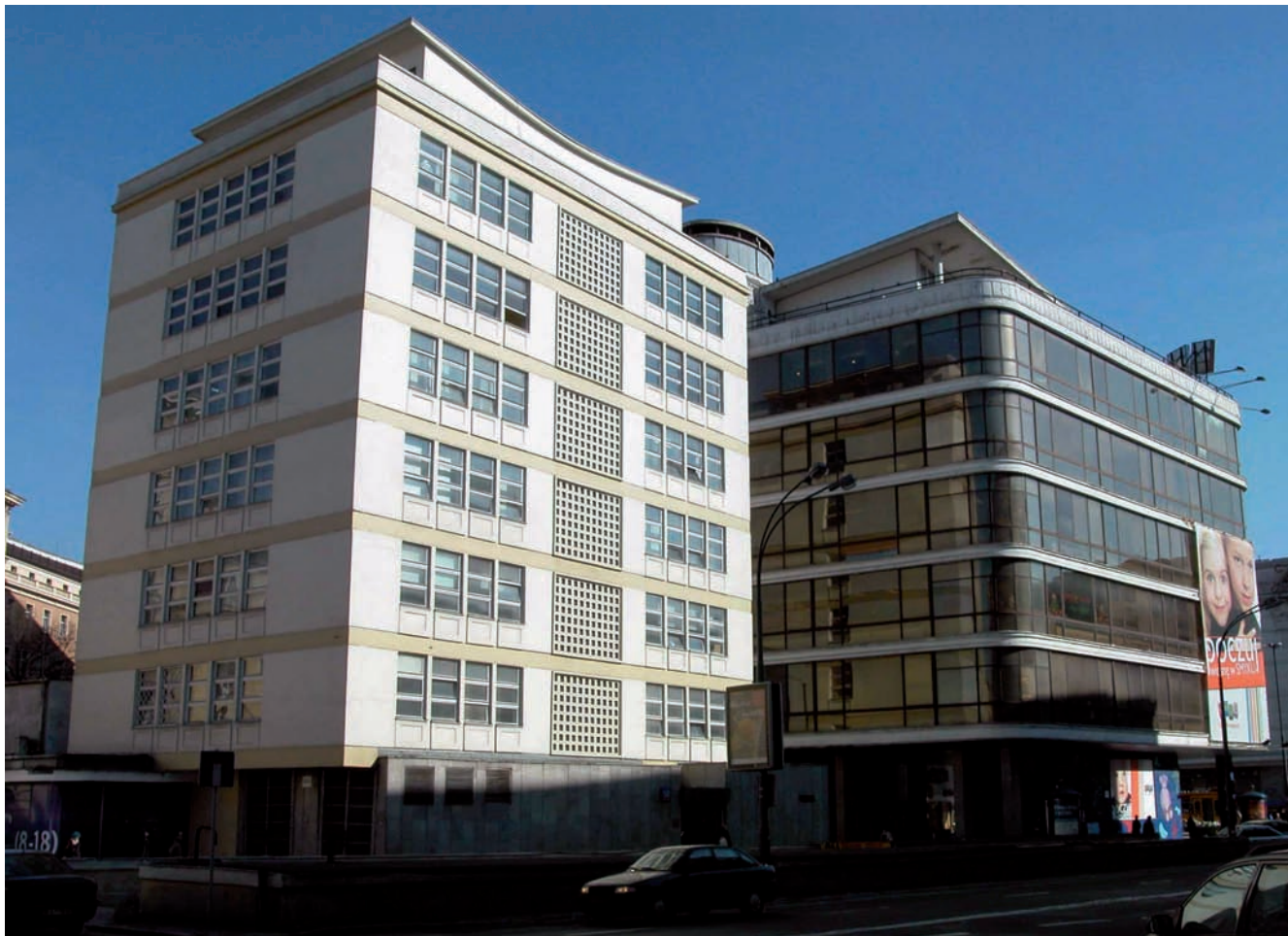
2. Część biurowa Centralnego Domu Towarowego przy al. Jerozolimskich w Warszawie, proj. Z. Ihnatowicz, J. Romański, 1948-1952 (fot. M. Czarnecki, 2005)
