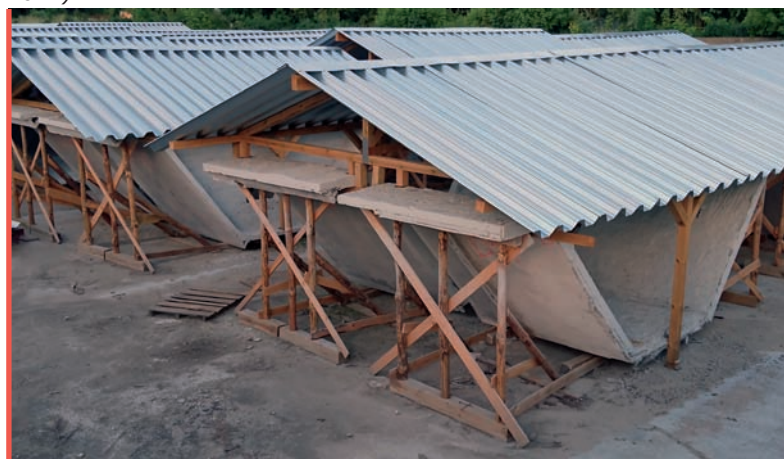
4. Elementy konstrukcji dachu Domu Meblowego „Emilia” w Warszawie, zmagazynowane po rozbiórce na dawnych terenach Domu Słowa Polskiego w Warszawie (fot. M. Czarnecki, 2017)
