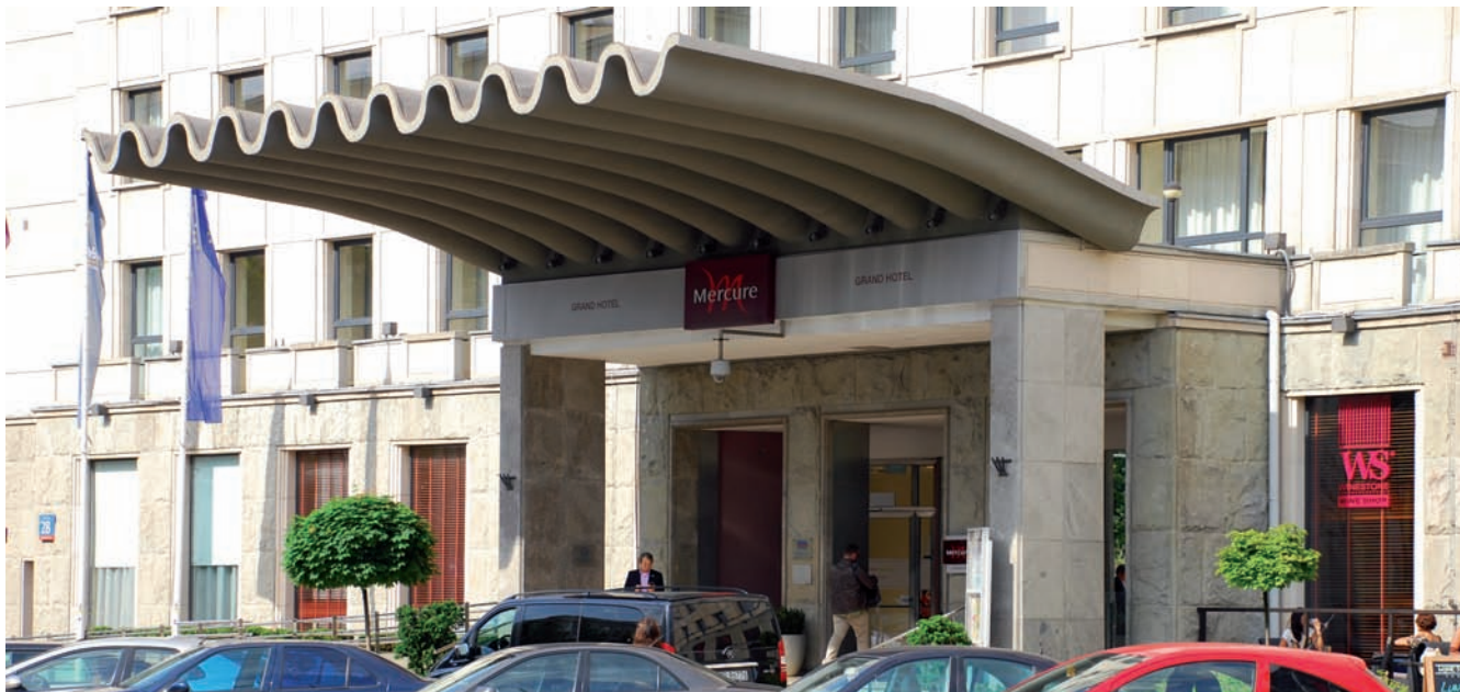
5. Zadaszenie wejścia głównego hotelu „Grand” przy ul. Kruczej w Warszawie, proj. S. Bieńkuński, S. Rychłowski, 1954-1959 (fot. M. Czarnecki, 2016)
