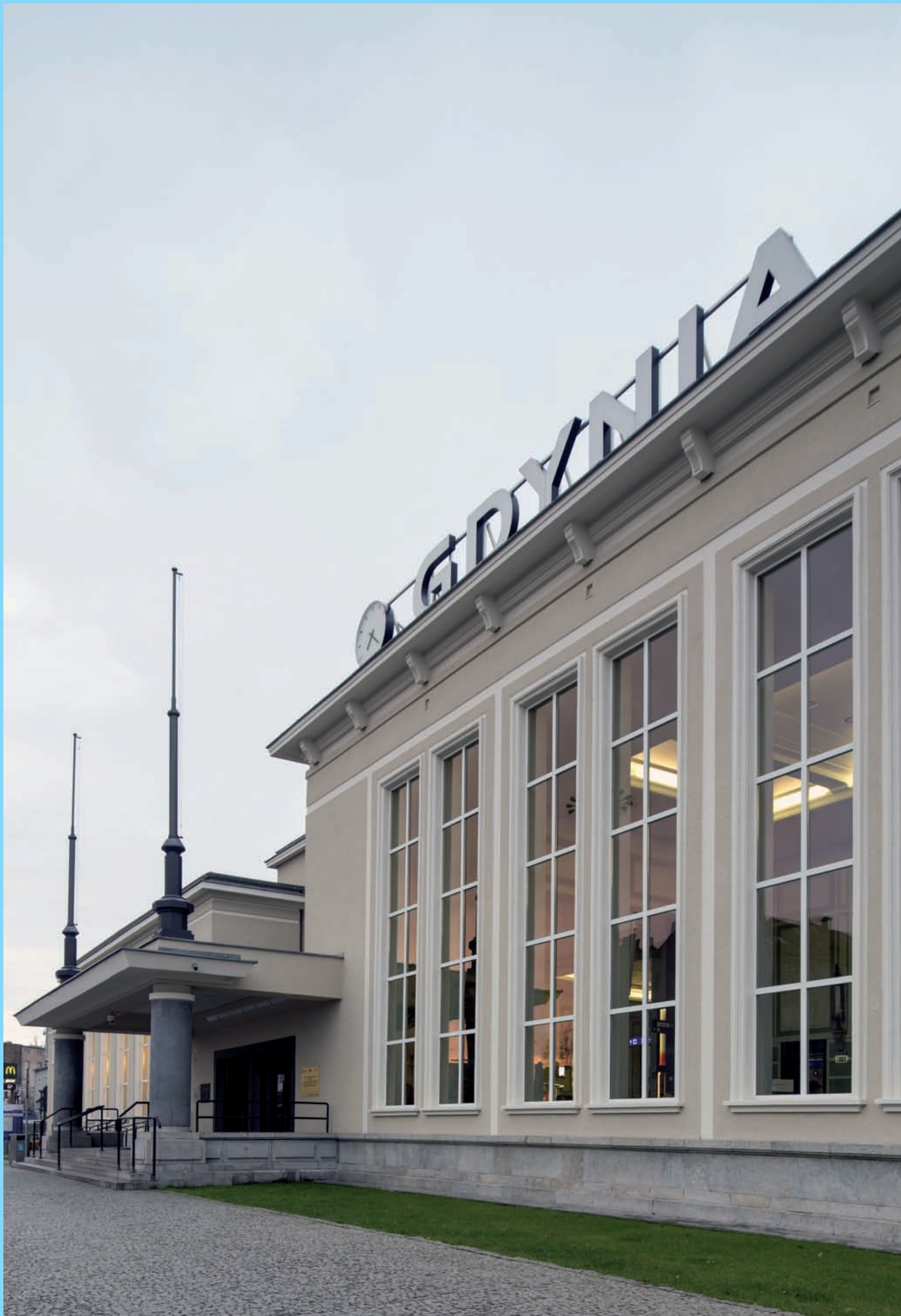
Dworzec kolejowy Gdynia Główna , pl. Konstytucji 1, 1950-55 r., proj. Wacław Tomaszewski
