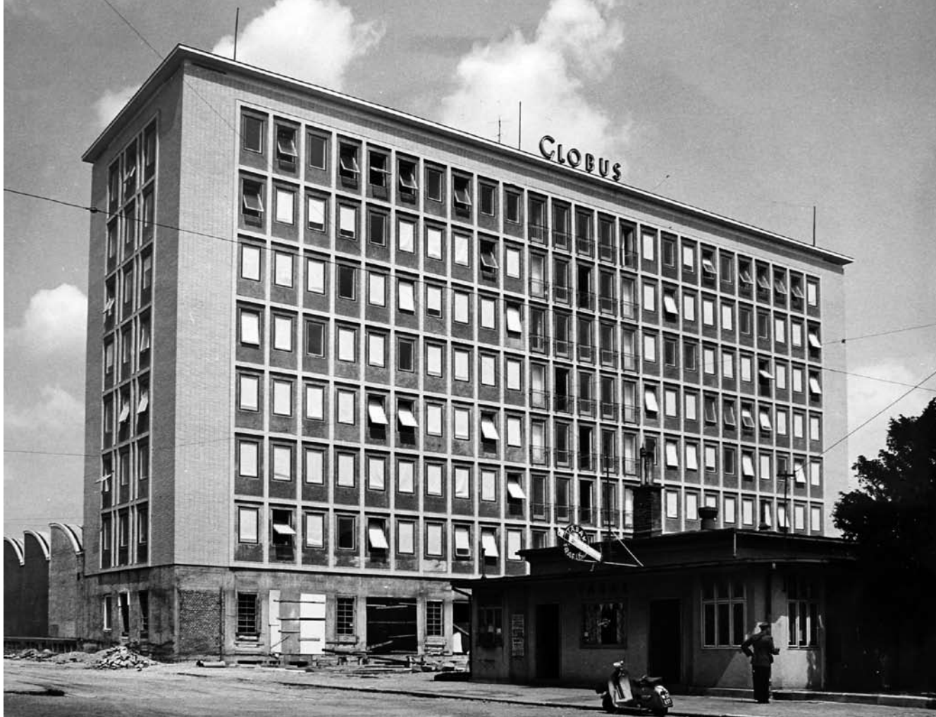
1. Wiedeń, budynek drukarsko-wydawniczy Globus (Dom Prawdy) i siedziba Komunistycznej Partii Austrii, Höchstädtplatz 3, architekci Margarete Schütte-Lihotzky, Wilhelm Schütte, Fritz Weber i Karl Franz Eder, 1954–1956 (źródło: KPÖ, archiwum austriackiej Partii Komunistycznej)
