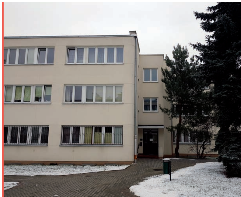
8. Osiedle WSM Rakowiec, wejście do bloku, stan z 2018 roku (fot. E. Perlińska-Kobierzyńska)
