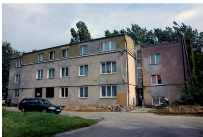
13. Dawny „Dom administracyjny” dla pracowników biurowych firmy „PAGED”, ul. Kampinowska 2, stan z 2011 r. (fot. A. Orchowska-Smolińska)
