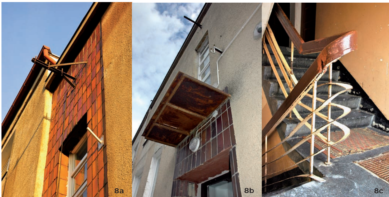
8. Elementy oryginalnego wykończenia budynków dawnego osiedla „PAGED” w Gdyni Oksywiu. 8 a. Okładzina klinkierowa w pasie pionu klatki schodowej oraz metalowe mocowanie napowietrznego przyłącza elektrycznego. Patrz także il. 7 a, b. 8 b. Zachowana okładzina klinkierowa w oprawie otworu drzwiowego oraz metalowe zadaszenie wejścia. 8 c. Wykończenie klatki schodowej: balustrada wykonana z metalowych prętów i płaskowników wraz z drewnianym pochwytem, posadzka z czarnego lastryko, metalowa wycieraczka (fot. A. Orchowska-Smolińska)
