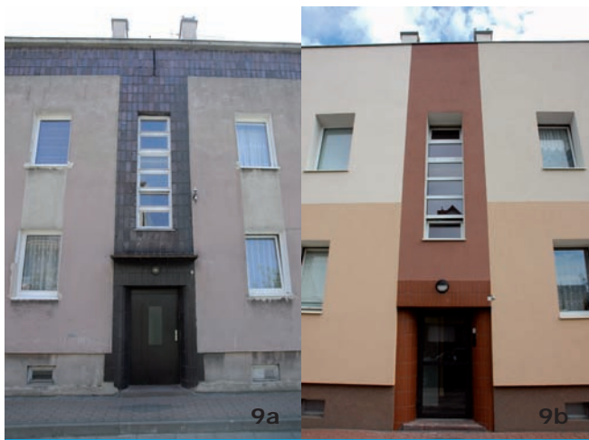
9. Rysunek i wykończenie elewacji budynku dawnego osiedla „PAGED” w Gdyni Oksywiu (ul. Tuchomska 7). 9 a. Charakterystyczne wykończenie okładziną klinkierową pionu klatki schodowej i pasa podokapowego, a pierwotnie także cokołu. Pola pomiędzy wykańczane były szarymi, matowymi płytkami okładzinowymi w układzie poziomym (usunięte i zamienione na tynk). Stan z 2009 r. 9 b. Wykończenie elewacji po pracach termomodernizacyjnych. Stan z 2011 r. (fot. A. Orchowska-Smolińska)
