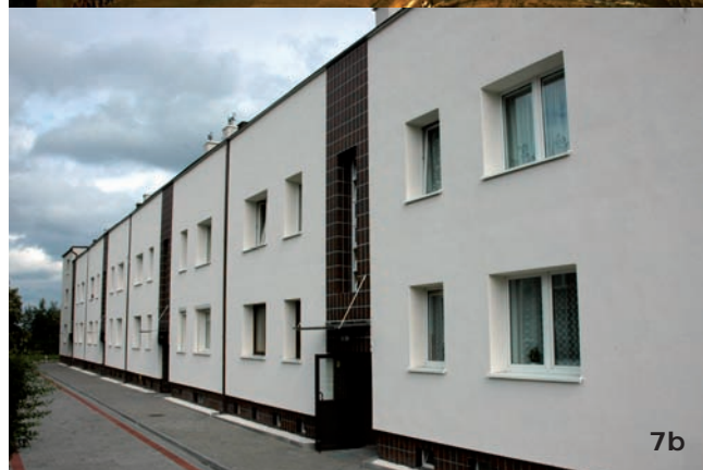
7. Budynek wielorodzinny dawnego osiedla „PAGED” w Gdyni Oksywiu (ul. Plk. Dąbka 183). 7 a. Widok elewacji w 2009 r. przed pracami termomodernizacyjnymi. 7 b. Stan elewacji po pracach remontowych wykonanych w 2010 r. (fot. A. Orchowska-Smolińska)
