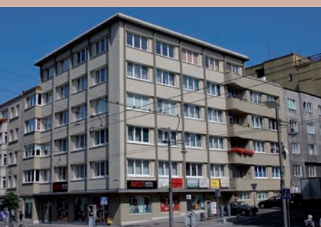
23. Kamienica Krenskiego, ul. Świętojańska 55 / ul. Żwirki i Wigury 4
