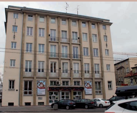
19. Budynek BGK, ul. 10 Lutego 8
