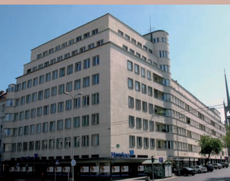
13. Budynek mieszkalny FE BGK, ul. 3 Maja 27/31
