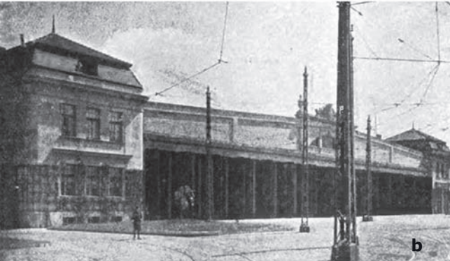
1. Warszawa, zespół zajezdni tramwajowej Zakładów Tramwajów Miejskich przy ul. Kawęczyńskiej na Pradze składający się z budynku garażowego (1923-1926) i tzw. budynku stacyjnego (1925-1931), proj. J. Dzierżanowski i P. Wędziągolski: a. plan sytuacyjny; b. widok elewacji czołowej budynku garażowego (źródło: Zarys historyczny i opis techniczny tramwajów miejskich i autobusów m. st. Warszawy, Warszawa 1933 )
