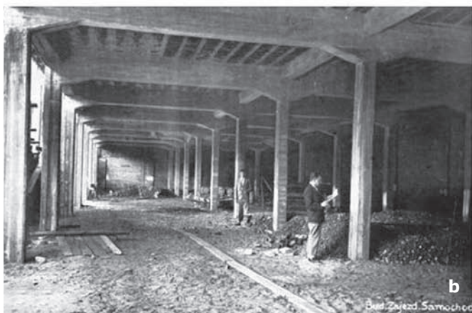
5. Warszawa, zajezdnia tramwajowa „Rakowiec” przy ul. Opaczewskiej na Ochocie, proj. J. Dzierżanowski (1928-1930): a. widok elewacji czołowej budynku garażowego (źródło: „Świat”, 1930 nr 27); b. wnętrze hali garażowej w trakcie budowy (źródło: Tow. Akc. Zakładów Przemysłowo-Budowlanych Fr. Martens i AD. Daab w Warszawie, Warszawa 1929); c. ukończone wnętrze hali garażowej (źródło: „Kronika Warszawy” 1930, nr 6)
