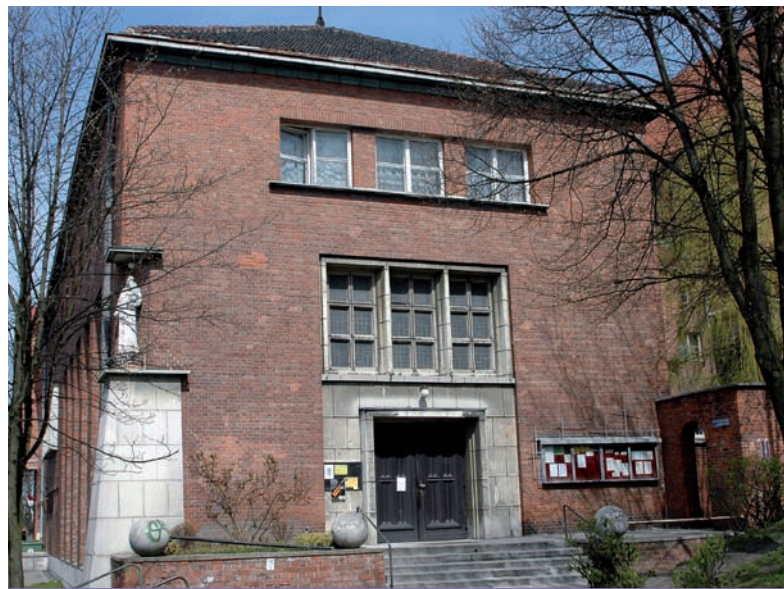
9. Kaplica oo. Franciszkanów p.w. Św. Antoniego Padewskiego na Wzgórzu Św. Maksymiliana w Gdyni, zbudowana w 1937 roku według projektu Zbigniewa Kupca i Tadeusza Kossaka z 1936 roku (fot. Maria Jolanta Sołtysik)
