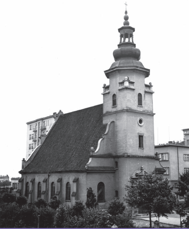
2. Neobarokowy kościół p.w. Najświętszej Marii Panny w śródmieściu Gdyni przy ul. Świętojańskiej, zbudowany w latach 1922-1927 prawdopodobnie według projektu Romana Wojkiewicza i Mariana Baranowskiego. Stan z lat pięćdziesiątych XX wieku (zbiory prywatne autorki)
