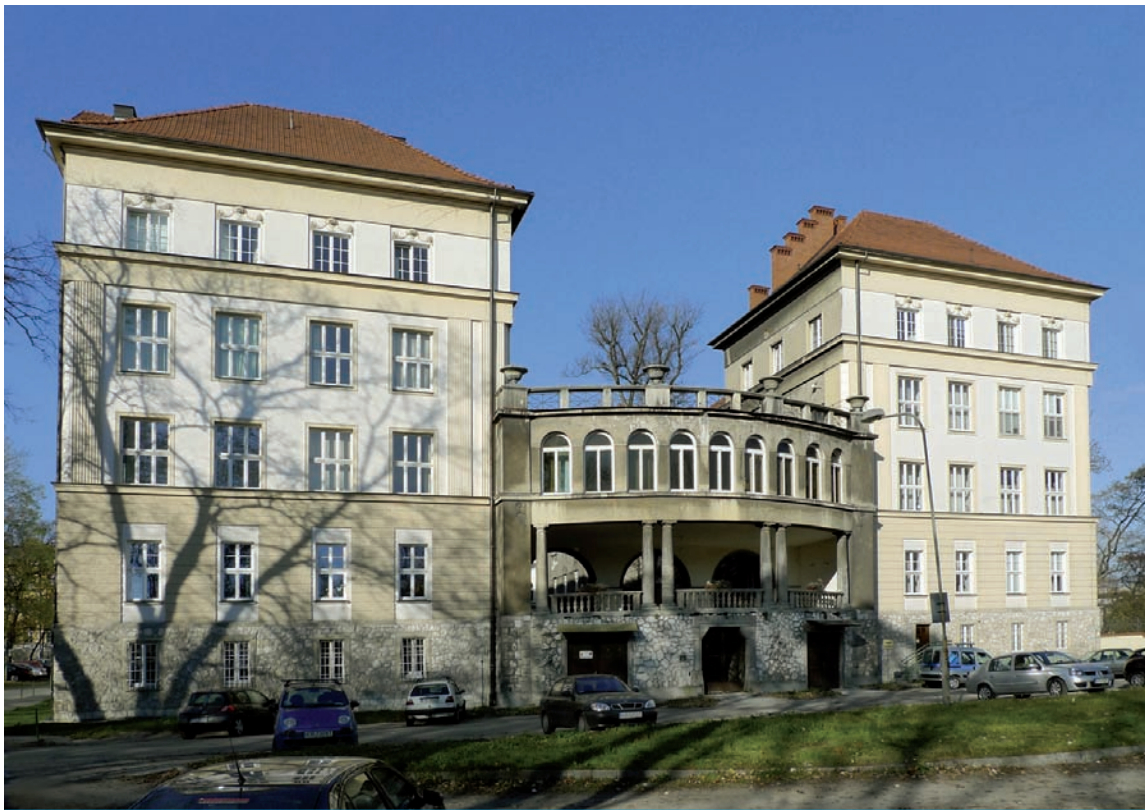
8. Klinika Ginekologiczna i Położnicza przy ulicy Kopernika 23 projektu Jerzego Struszkiewicza i Maksymiliana Burstina (1920-1932), w trakcie remontu konserwatorskiego. Stan z roku 2012 (fot. Marek Pawłowski)
