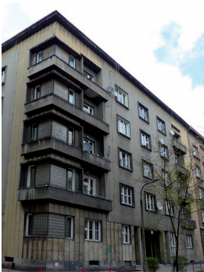
4. Kamienica przy ul. Sereno Fenn'a 6, wzniesiona w latach 1938-1940 według projektu Alfreda Düntucha i Stefana Landsbergera. Na elewacji widać uskokowo opracowaną okładzinę z piaskowca połączoną z partiami tynkowanymi (fot. M. Szkoła, 2016)
