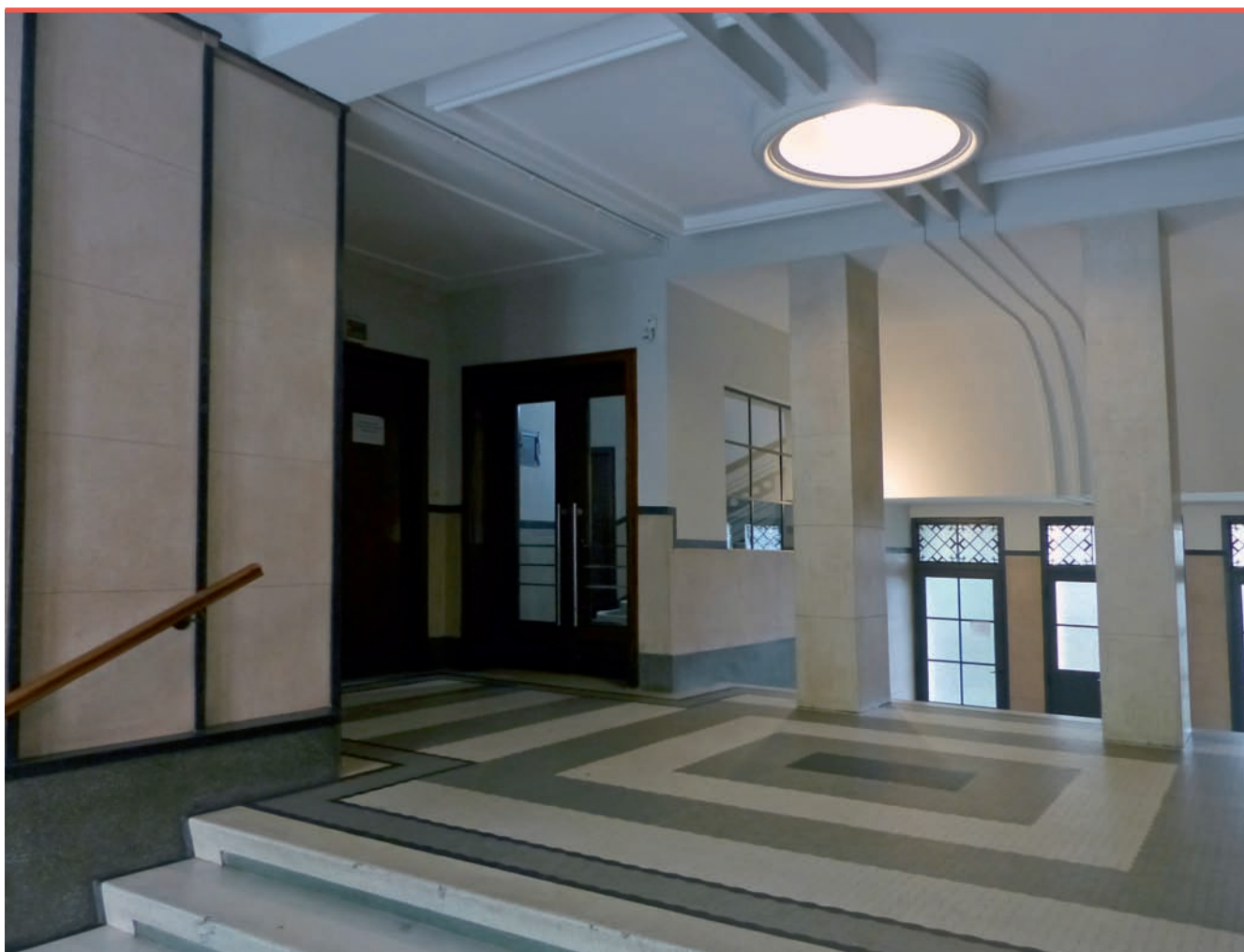
6. Hol kamienicy przy ul. Sereno Fenn'a 6 – układ i kolorystyka tzw. gorsecików na posadzce koresponduje z częścią posadzek wykonanych z lastryka. Na ścianach uskokowo wykonane płyty z różowego lastryka nawiązują do układu piaskowca na elewacji (fot. M. Szkoła, 2016)
