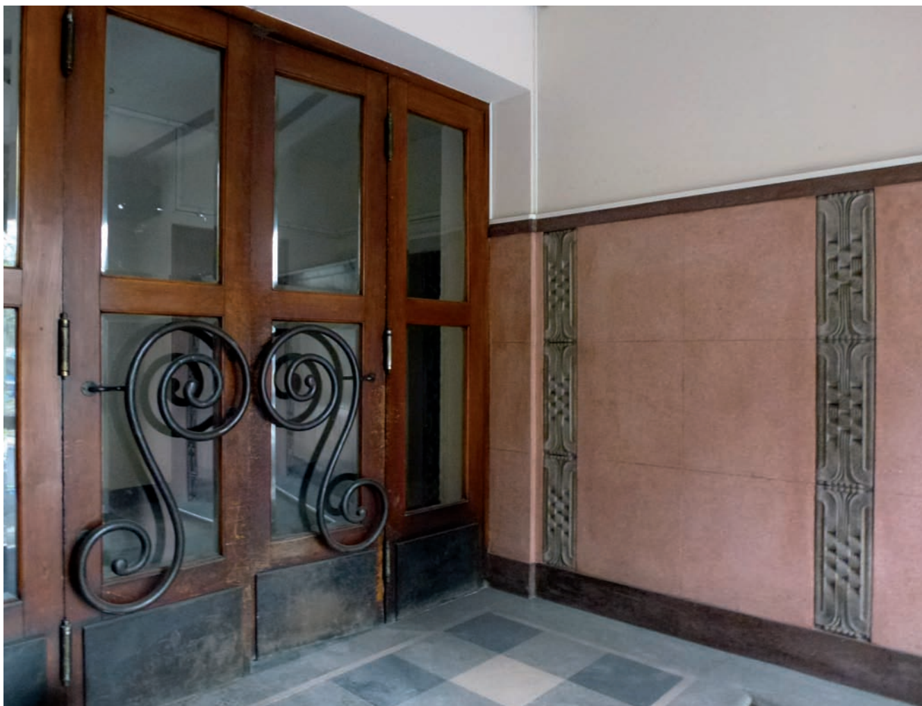
7. Dekoracja sieni kamienicy przy al. J. Słowackiego 15a z lat 1935-1936, wykonana z wielobarwnego lastryka. Na ścianach płyty z różowego lastryka rozdziela odlew ze sztucznego kamienia z motywem roślinnym (fot. M. Szkoła, 2016)
