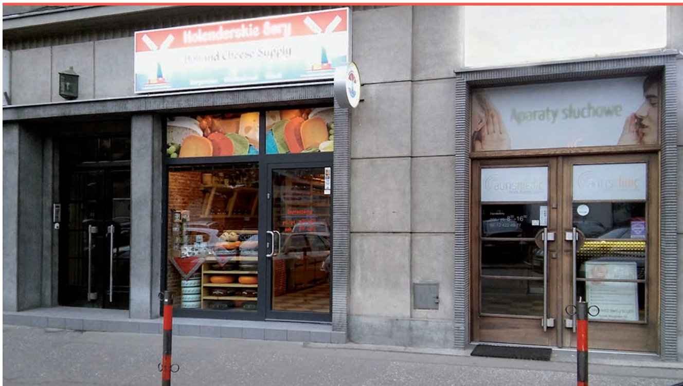
8. Fragment elewacji kamienicy przy Rynku Kleparskim 12, zbudowanej w 1938 r. według projektu Alfreda Düntucha i Stefana Landsbergera. Po prawej stronie współcześnie wykonane obramienie witryny z obróbką kamieniarską w formie żłbkowania (fot. M. Szkoła, 2016)
