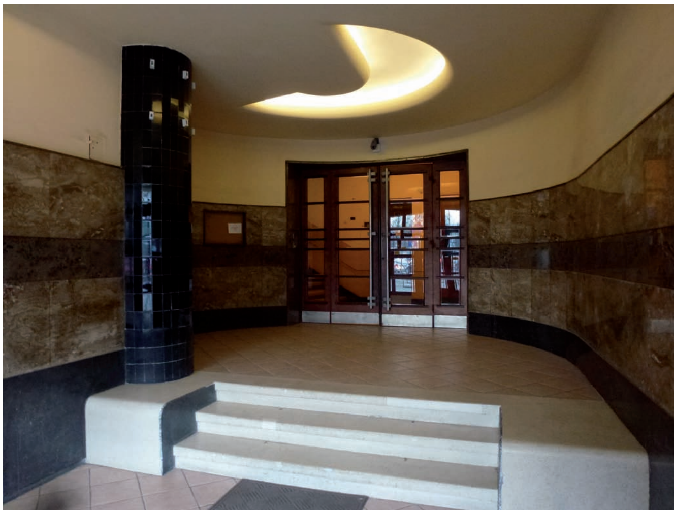
3. Hol kamienicy zbudowanej w 1937 r., w którym współczesna posadzka z płytek gresowych nie koresponduje z lastrykowymi schodami i kamienną okładziną ścian (fot. M. Szkoła, 2016)
