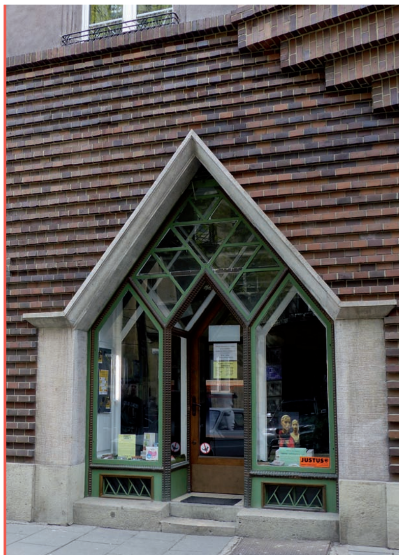
9. Fragment elewacji kamienicy przy pl. Inwalidów 6 po zakończeniu prac konserwatorskich – widoczna częściowo zrekonstruowana dekoracja witryny ze sztucznego kamienia (fot. M. Szkoła, 2016)
