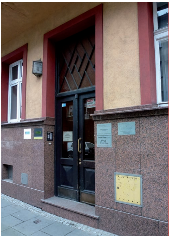
2. Przykład niekorzystnych działań podjętych w trakcie remontu fasady kamienicy zbudowanej w 1931 r. - tynk kamieniarski zastąpiono okładziną z polerowanego granitu (fot. M. Szkoła, 2016)
