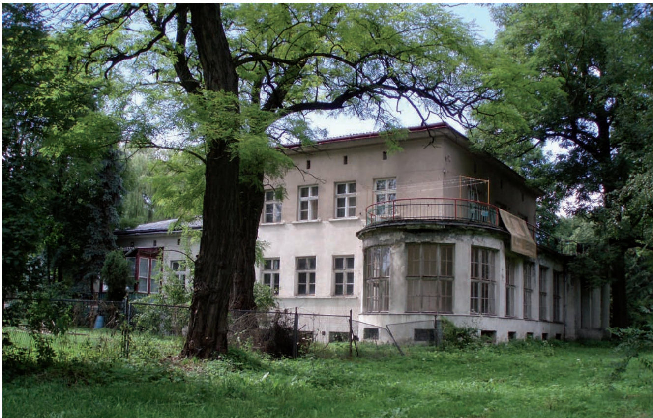
8a. Skrzyszowice, dwór B. Kleszczyńskiego jr., 1939-1944, widok od południa (fot. J. K. Lenartowicz 2014)
