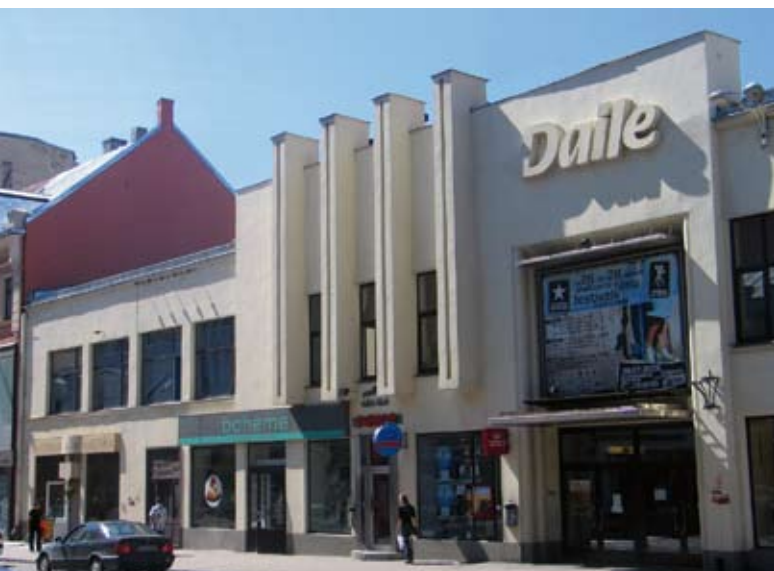
4. Frontowa elewacja kinoteatru „Daile” w Rydze, Teodors Hermanovskis, 1936-1937. Fot. R. Čaupale 2008.
