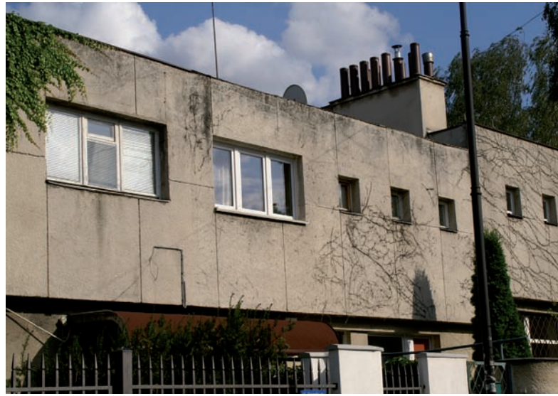
6. Fragment of the terraced housing project for the employees of Zakład Ubezpieczeń Społecznych - ZUS (Social Insurance Company) in Dziennikarska St. in Warsaw-Żoliborz, designed by B. Lachert, R. Piotrowski and J. Szanajca (1934-1935). Photo by J. Roguska, 2009
