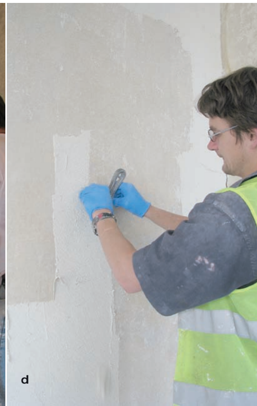
24. Brno (Czechy), Dom Tugendhatów, 1930, Ludwig Mies van der Rohe: a. mieszkanie szofera, balustrada galerii, próba odsłonięcia mikrodlutem i kolejne kompresy z węglanem amonu o neutralnych brzegach (HAWK 2004, fot. Ivo Hammer); b. mieszkanie szofera, balustrada galerii, „próba” działania kompresu z węglanem amonu: oczyszczanie i przemiana tynku w wapno, zmniejszenie zasolenia (HAWK, fot. Ivo Hammer 2004); c. górny taras, ściana północna – szybkie nałożenie kompresu w celu oczyszczenia i ponownego nałożenia tynku za pomocą kielni. Skład kompresu: 1 kg węglanu amonu, pulpa bukowa ARBOCEL BC 200 0,5 kg, kaolin (głina biała) 0,5 kg, woda zdemineralizowana 4.5 -5 l. (Art KODIAK, Michal Pech, fot. Ivo Hammer 2011); d. górny taras, północna ściana – szybkie usuwanie kompresu celulozowo-kaolinowo-amonowego za pomocą szpatułki, (Art KODIAK, Michal Pech fot. Ivo Hammer 2011)
