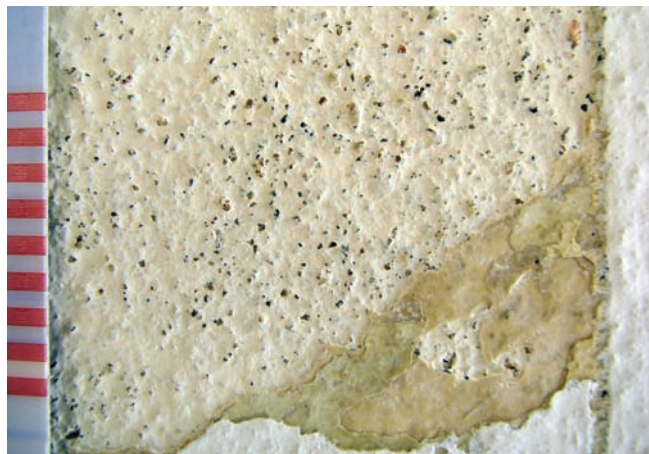
14. Brno (Czechy), Dom Tugendhatów, 1930, Ludwig Mies van der Rohe, elewacja południowa, II kondygnacja, powierzchnia w trakcie czyszczenia wykonywanego przez konserwatora-restauratora przy użyciu mikrodluta pneumatycznego: oryginalna powierzchnia hydraulicznego tynku wapiennego wygładzona deską drewnianą i przemyta bardzo rzadką farbą wapienną pigmentowaną piaskiem mułowym; trzy brązowe wapnowania, zmienione; ostatnia warstwa cementowo-żywiczna z 1985 r. (fot: Ivo Hammer 2011)
