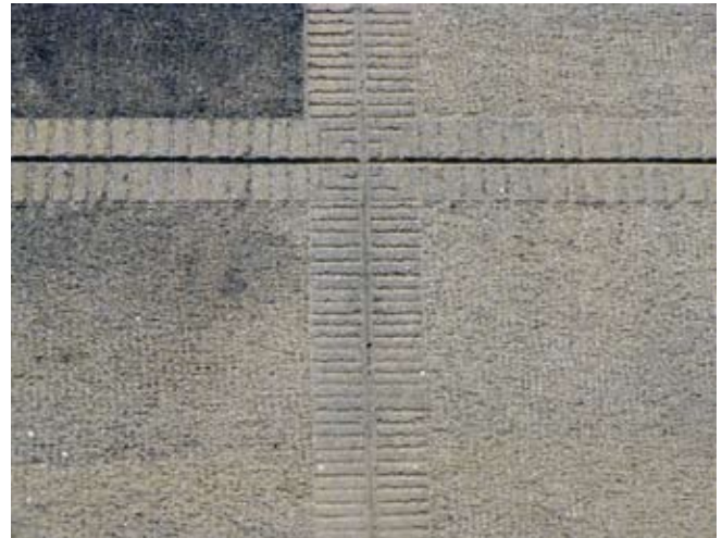
17. Fragment elewacji kamienicy przy ul. Świętojańskiej 49 w Gdyni z tynkiem imitującym płyty kamienne.
