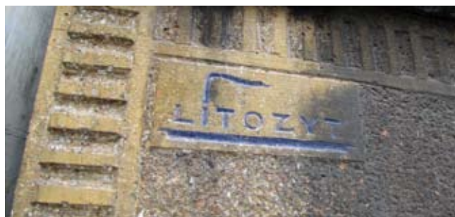
24. Fragment elewacji kamienicy przy ul. Żuławskiego 8a/ róg Kolberga 17 w Krakowie wykończonej tynkiem kamieniarskim z logiem firmy Litozyt.
