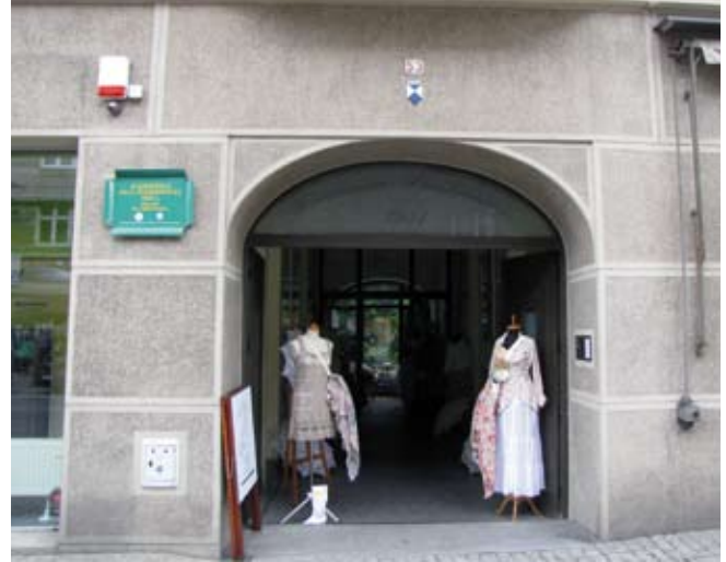
16. Tynk kamieniarski na kamienicy przy ul. Świętojańskiej 53 w Gdyni, stylizowany na płyty kamienne
