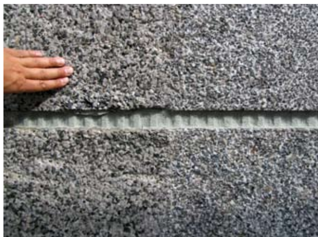
10. Tynk zmywany na elewacji kamienicy przy ul. Świętojańskiej 105 po odrestaurowaniu. Z lewej strony tynk oryginalny, z prawej tynk odtwarzany.
