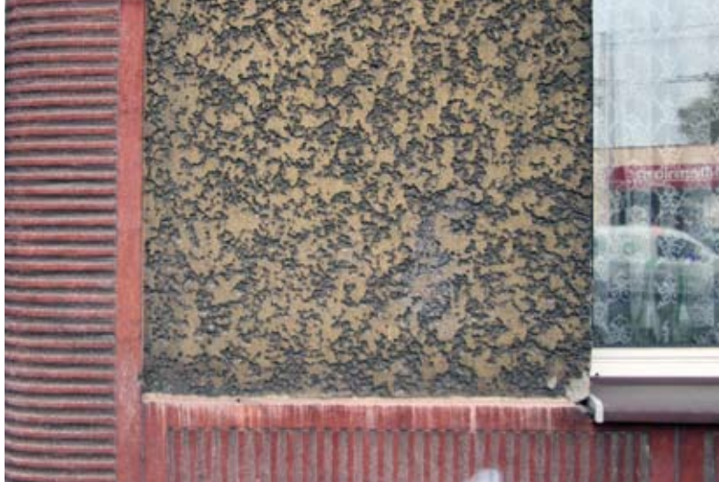
4. Tynk gniazdkowany w kolorze żółtym, zakomponowany z tynkiem kamieniarskim w kolorze czerwonym na elewacji budynku przy ul. Chylońskiej 39 w Gdyni
