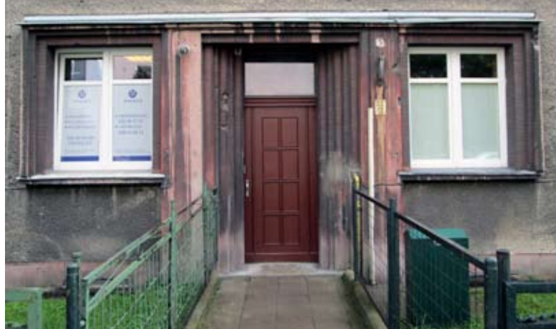
26. Portal przy ul. Bema 5 w Gdyni wykończony tynkiem kamieniarskim przed pracami konserwatorskimi
