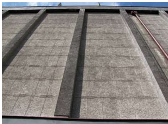
7. Tynk cyklinowany wykonany po II wojnie na elewacji kościoła NSPJ przy ul. Armii Krajowej w Gdyni
