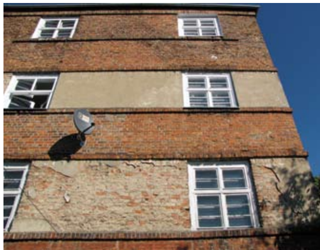
3. Fragment elewacji budynku w zespole Łuszczarni Ryżu z 1928 r. z wykończeniem tynkiem zwykłym, skonstrastowanym z licem ceglany, stan w 2012 r.
