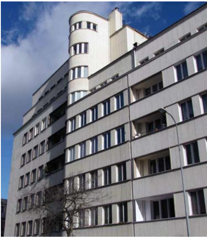
11. Budynek przy ul. 3 Maja 27-31 z elewacjami wykończonymi naturalnym kamieniem (część lewa do loggii) i tynkiem imitującym płyty kamienia (część prawa z loggiami).
