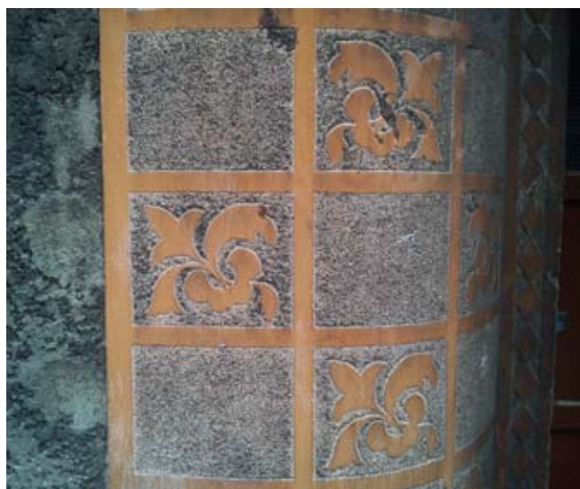
22. Fragment dekoracji portalu kamienicy przy ul. Moniuszki 26 w Toruniu z powtarzalnym motywem dekoracyjnym (fot. Alina Limańska).
