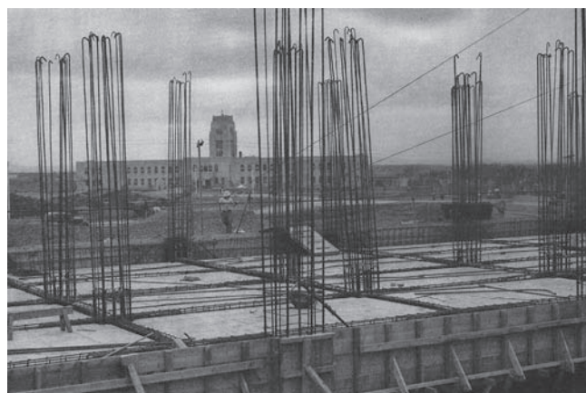
4. Zdjęcie przedstawiające błyskawiczną budowę Hsinking i jeden duży budynek w trakcie budowy, zlokalizowany na przeciw Ministerstwa Edukacji, 1934
