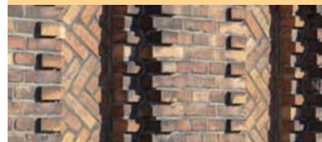
6b. Chłodnia Portowa, detal elewacji 6b. Port Cold Store, detail of the facade
