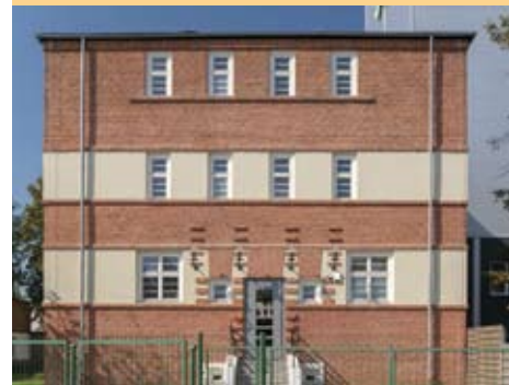
5b. Budynek administracyjny Łuszczarni Ryżu 5b. The administration building of Rice Shelling Hall Complex
