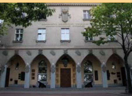
2a. Budynek Żeglugi Polskiej 2a. Polish Steamship Co Building
