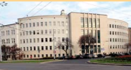
14a. Gmach Sądu, elewacja frontowa 14a. The Court Building, the front elevation
