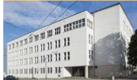
14b. Gmach Sądu, elewacja od strony ulicy Jana z Kolna 14b. The Court Building, the elevation from the side of Jana z Kolna Str.
