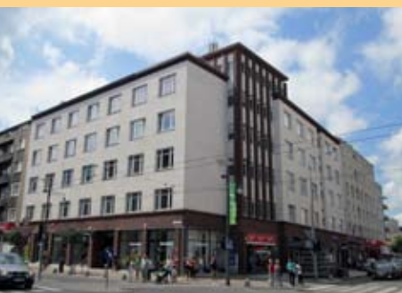
22a. Kamienica „Paged” 22a. The „Paged” Apartment House
