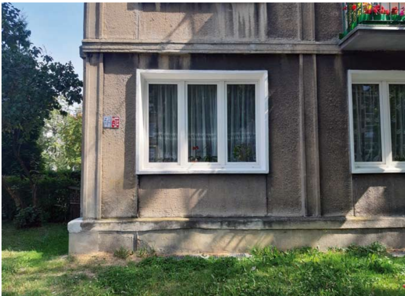
4. Tychy, Osiedle C, ul. Cyganerii, fragment prefabrykowanej ściany, seria „T”, arch. Stanisław Wąs z zespołem, ok. 1957 (fot. A. Syska, rok 2019)
