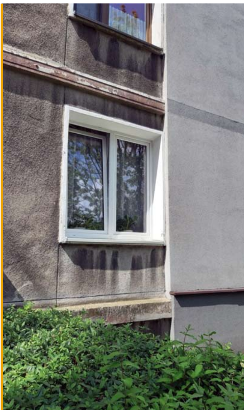
9. Tychy, termomodernizacja fragmentu bloku na Osiedlu C, seria „T”, arch. Stanisław Wąs z zespołem, ok. 1956 (fot. A. Syska, 2019)
