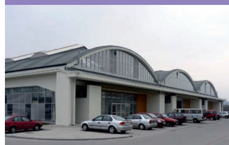
33. Zajezdnia autobusowa, al. Zwycięstwa 96/98 – po adaptacji na Pomorski Park Naukowo Technologiczny
