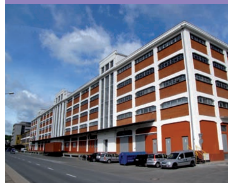
35. Magazyn Długoterminowy „H”, ul. Polska 17 – po przeprowadzeniu prac restauratorskich
