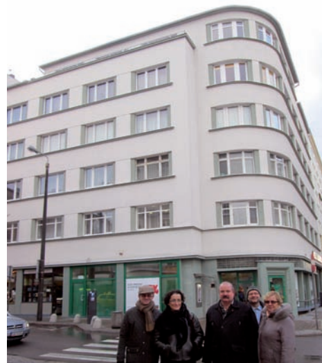
32. Kamienica przy ul. Świętojańskiej 89 po pracach restauratorskich
