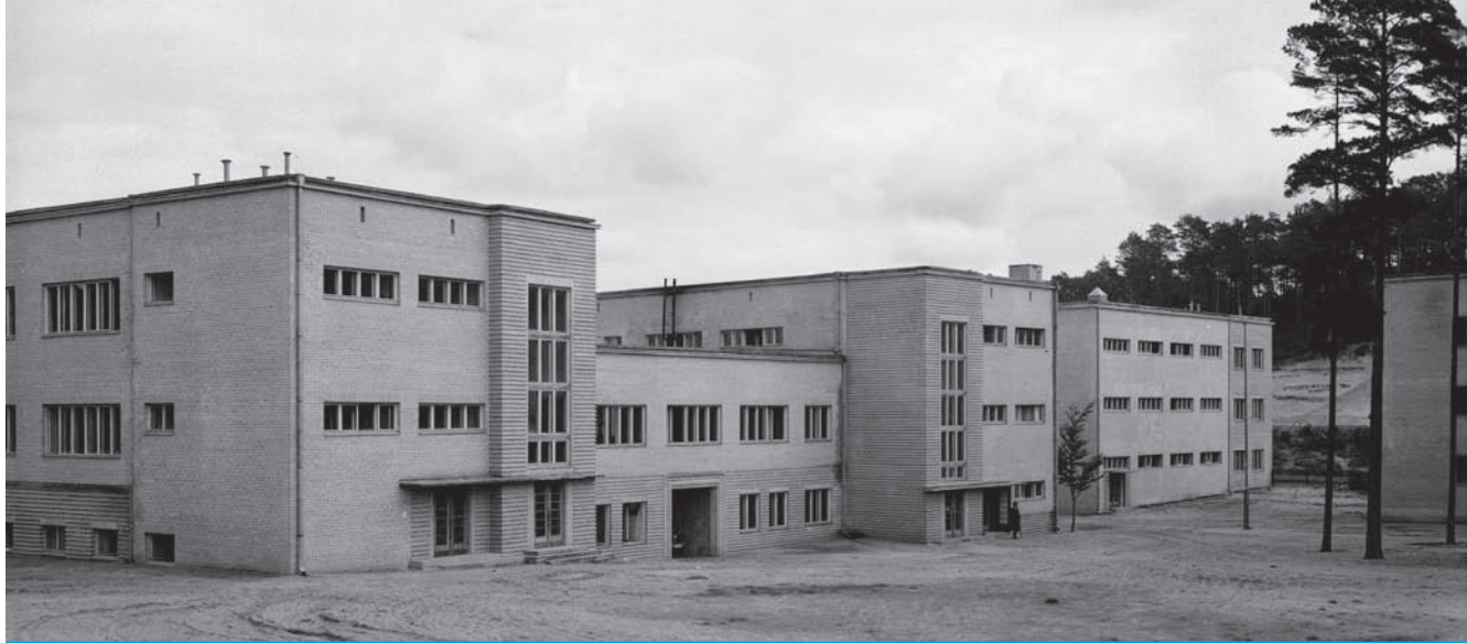
2. Elewacja południowa budynku administracyjno-jadalnego, w głębi elewacja południowa budynku dezynfekcyjno-kąpielowego (stan z lat trzydziestych XX w.), źródło: zbiór fotografii Muzeum Miasta Gdynia, sygn. MMG-HM-II-527-118
