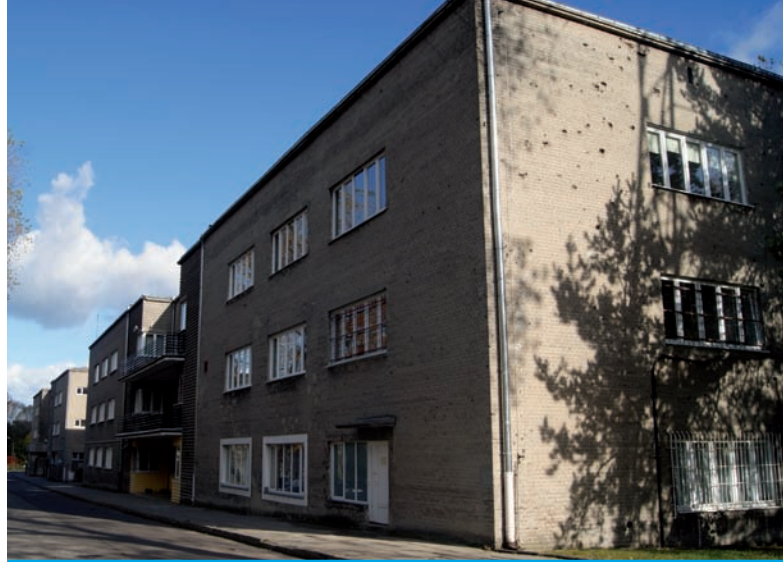
7. Fasada zachodnia budynku sypialnego (stan obecny), (fot. Anna Postulszna)
