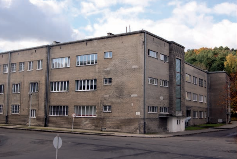
8. Budynek administracyjno-jadalny, elewacja północna, stan obecny (fot. Anna Posłuszna)
