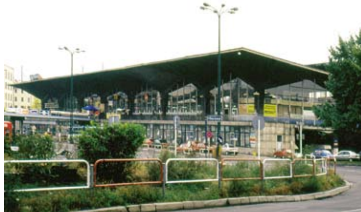
6. Katowice, dworzec PKP, proj. Wacław Kłyszewski, Jerzy Mokrzyński i Eugeniusz Wierzbicki, 1966-1972. Budynek uważany za najcenniejszy polski przykład brutalizmu, wobec którego Śląski Konserwator Zabytków odmówił wpisu do rejestru zabytków, w wyniku czego budynek rozebrano i zastąpiono nowym gmachem (fot. J. Lewicki 2007)
