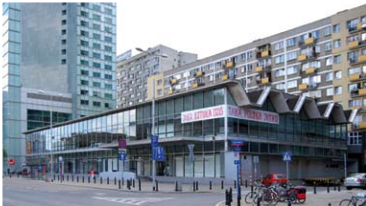
1. Warszawa, pawilon „Emilia”, proj. Marian Kuźniar, Czesław Wagner, 1967-69, wpisany z błędami proceduralnymi do ewidencji zabytków i później z niej usunięty. (fot. J. Lewicki 2013)
