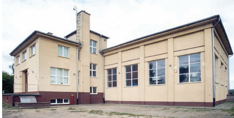
7. Rumia, Główne Ujęcie Wody ZWiK w okolicy ul. Pomorskiej (widok na elewację frontową z głównym wejściem), proj. Jerzy Müller (?), budowa 1933-1934 r., nadbudowa Kazimierz Borkiewicz, 1934 r. (fot. Leszek Żurek / Muzeum Miasta Gdyni, 2021 r.)
