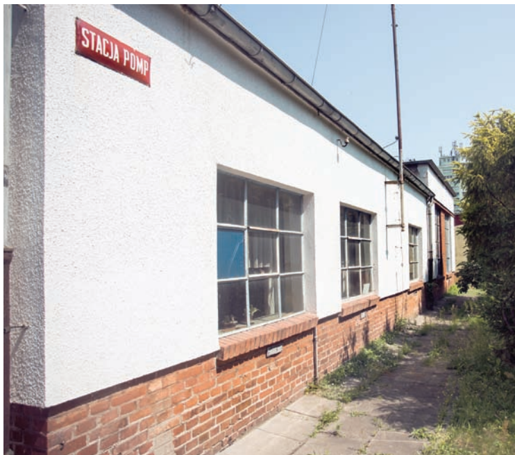
12. Gdynia, stacja pomp przy ul. Jana z Kolna 14, projektant nieustalony, budowa 1929-1930, rozbudowa Kazimierz Borkiewicz 1930 r. (fot. Leszek Żurek / Muzeum Miasta Gdyni, 2021 r.)
