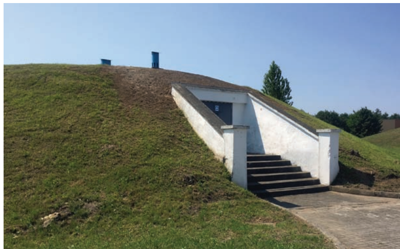
5. Gdynia-Obłuże, zbiornik wody przy ul. Ledóchowskiego, proj. Karol Pomianowski, budowa 1931 r. (fot. Leszek Żurek, Muzeum Miasta Gdyni, 2021 r.)
