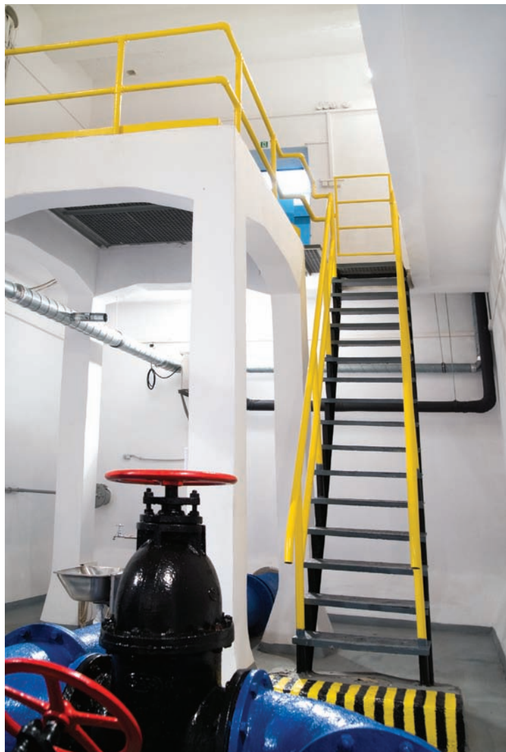
2. Gdynia, zbiornik wody i stacja hydroforowa w okolicy ul. Kwidzyńskiej (wnętrze pomieszczenia zasuw), proj. Karol Pomianowski (?), budowa 1929 r., rozbudowa Stanisław Dobilis 1932 r., (fot. Leszek Żurek, Muzeum Miasta Gdyni, 2021)
