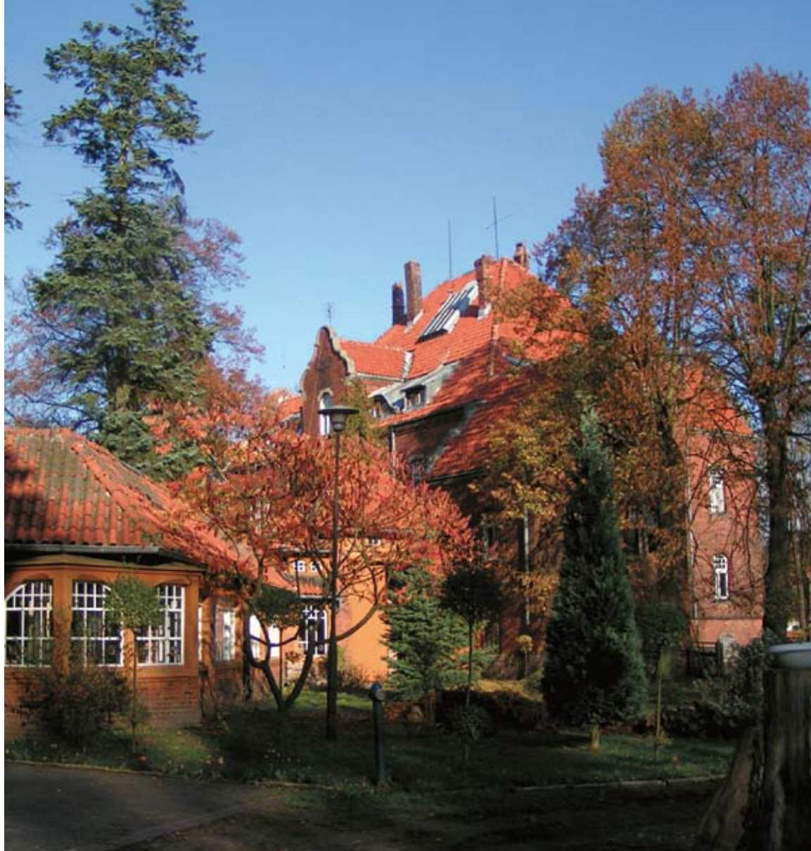
2. Dom Lekarza połączony z budynkiem sanatoryjnym parterowym łącznikiem (fot. B. Bielinis-Kopeć)
