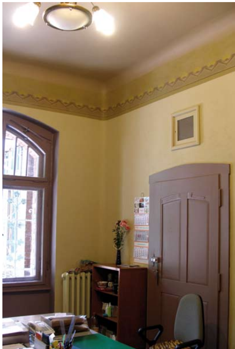
5. Dawny pokój dla pań po pracach konserwatorsko-restauratorskich (fot. B. Bielinis-Kopec)
