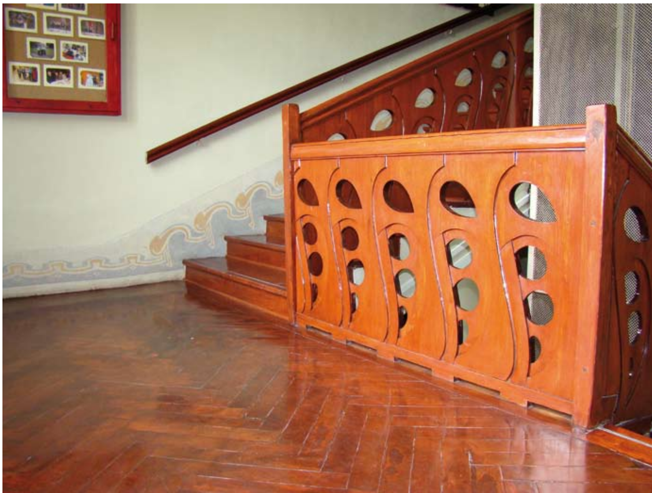
8. Balustrada głównej klatki schodowej w budynku sanatoryjnym (fot. B. Bielinis-Kopeć)
