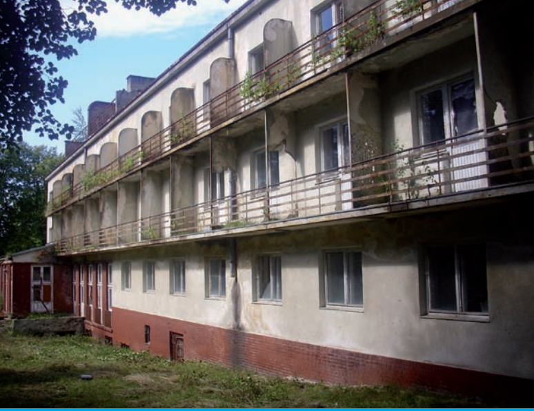
2. Oficerski Dom Wypoczynkowy w Truskawcu – elewacja południowa, 2015 (fot. Weronika Drohobycka-Grzesiak)
