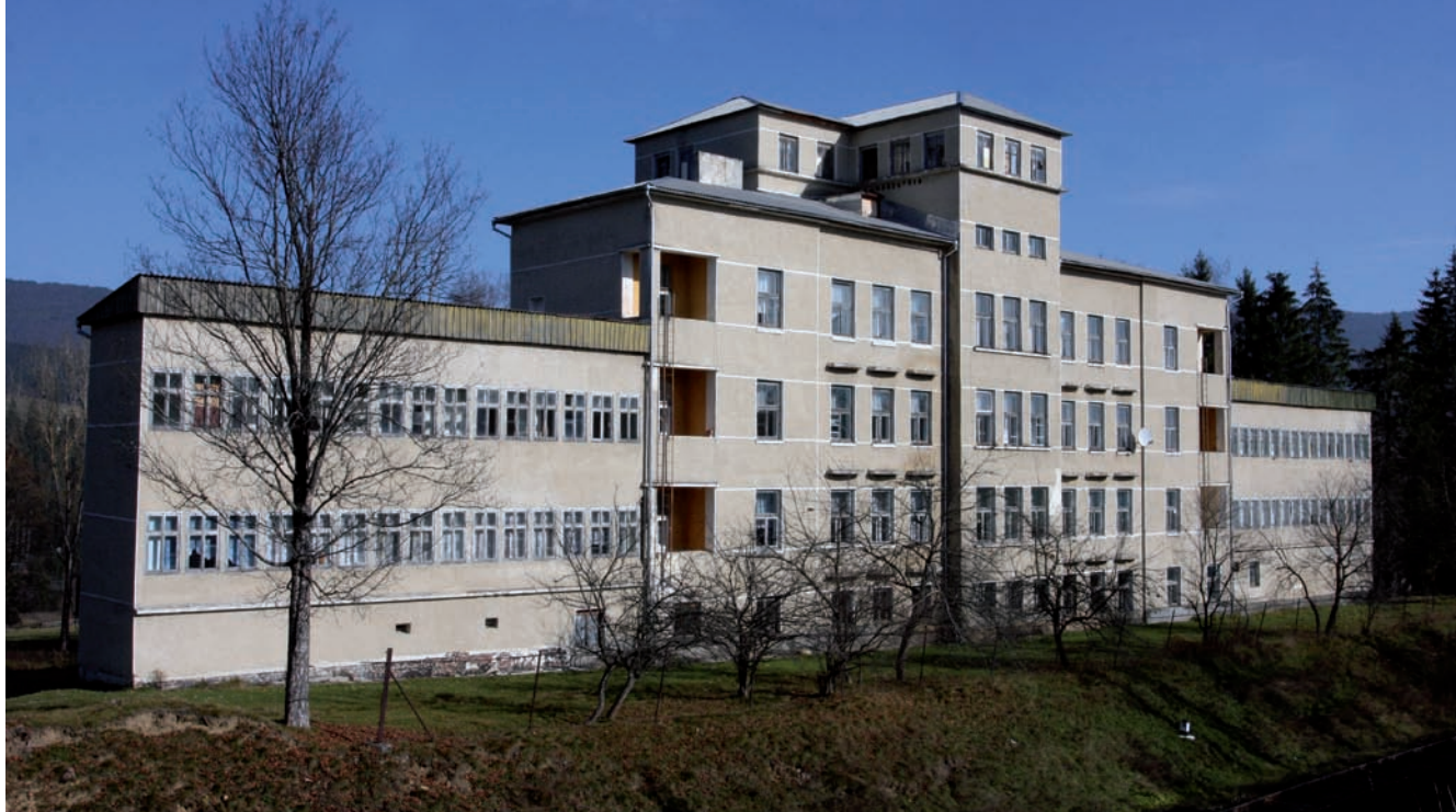
8. Sanatorium żydowskiej młodzieży akademickiej w Worochcie, proj. Józef Awin, 1926: fasada południowa (fot. Weronika Drohobycka-Grzesiak, 2015)
