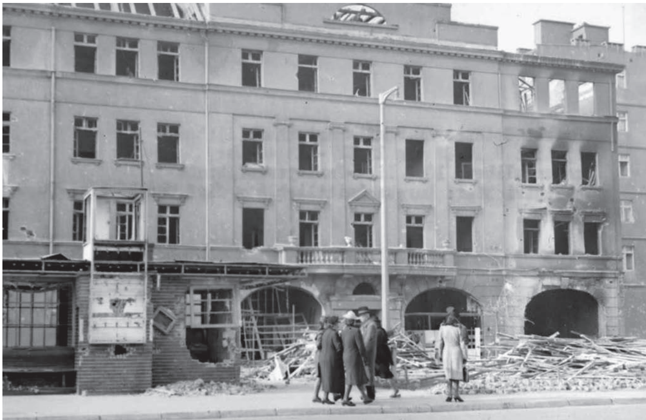
1. Budynek szpitala na Placu Kaszubskim (źródło: Muzeum Miasta Gdyni) 1. Hospital building in Kaszubski Square (source: Gdynia City Museum)
