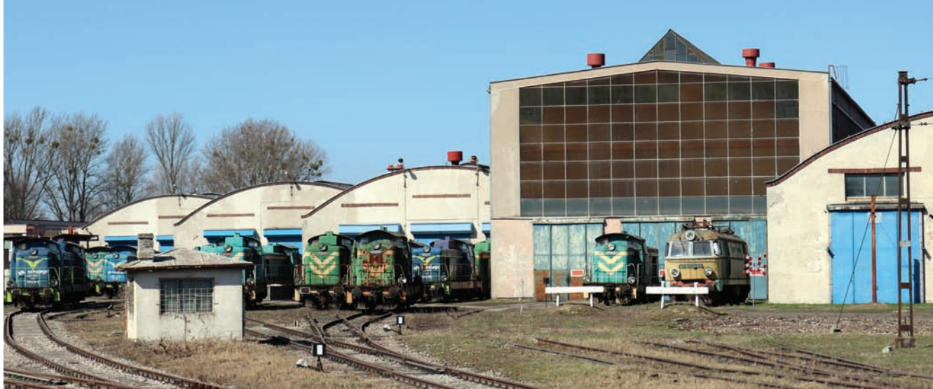
4. Warszawa, Parowozownia i Elektrowozownia Odolany, ul. Przyce 17, proj. Kazimierz Stefan Brandt, 1945-1946 (fot. Jakub M. Andrzejewski, 2018)
