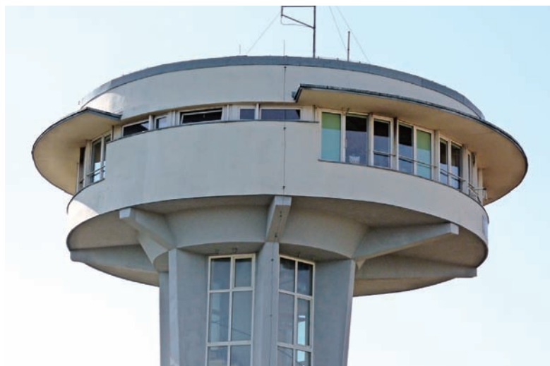
8. Warszawa, nastawnia na stacji Warszawa Wschodnia, ul. Chodakowska 100, proj. Zygmunt Kęska, 1969 (fot. Jakub M. Andrzejewski, 2016)
