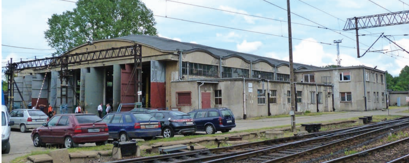
1. Warszawa, hala elektrowozowni na stacji postojowej Grochów (Olszynka Grochowska), ul. J. Chłopickiego 53, proj. Wacław Żenczykowski, 1939 (fot. Jakub M. Andrzejewski, 2013)
