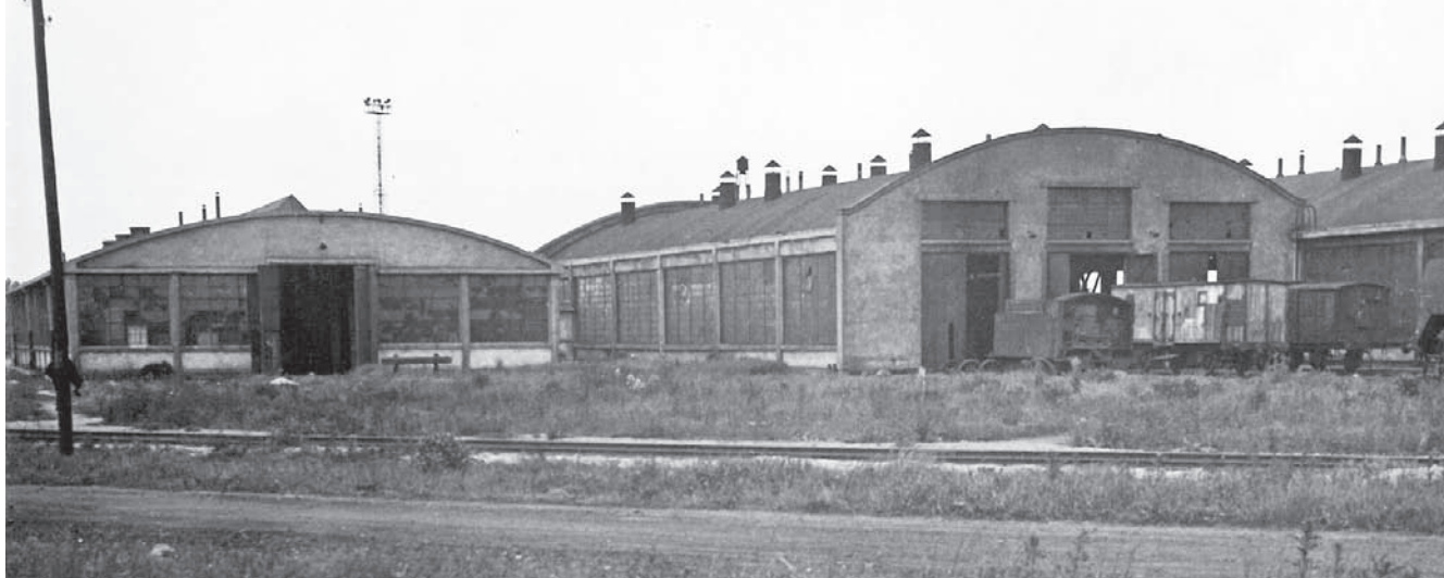
3. Warszawa, Parowozownia i Elektrowozownia Odolany, ul. Przyce 17, proj. Kazimierz Stefan Brandt, 1945-1946 (źródło: Stacja Muzeum w Warszawie, arch. 147, archiwum zdjęciowe muzeum, 1951)
