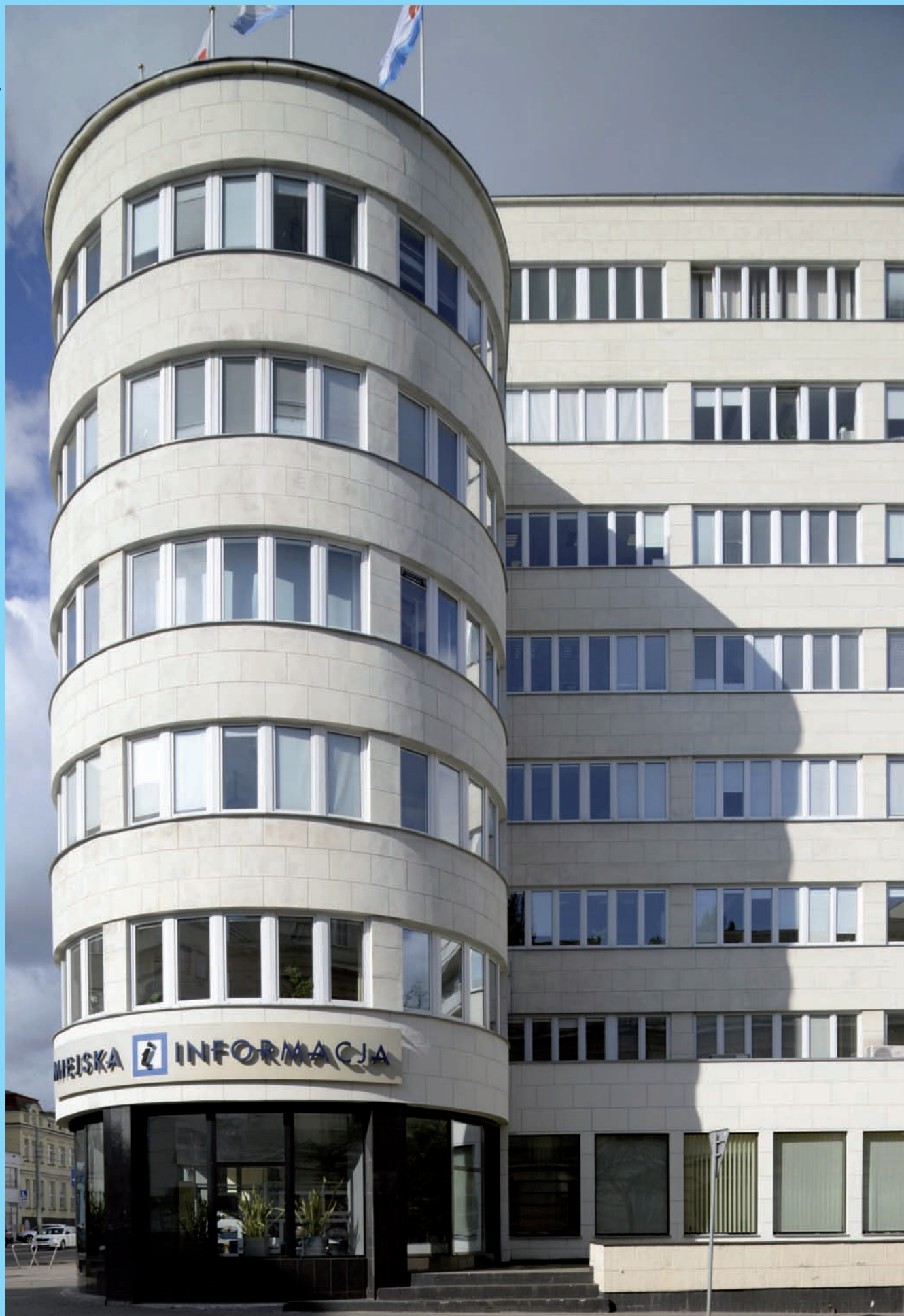
Budynek Urzędu Miasta Gdyni przy ul. 10 Lutego 24, zbudowany w latach 1934-1936 według projektu Romana Piotrowskiego, jako biurowiec ZUS. Po II wojnie światowej przez długie lata był siedzibą Polskich Linii Oceanicznych. Wpisany do wojewódzkiego rejestru zabytków w 1972 r., jako pierwszy modernistyczny budynek Gdyni. W 2008 r. został zakupiony przez Gminę Miasta Gdyni.
