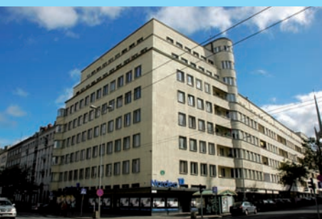
14. Budynek mieszkalny FE BGK, ul. 3 Maja 27/31
