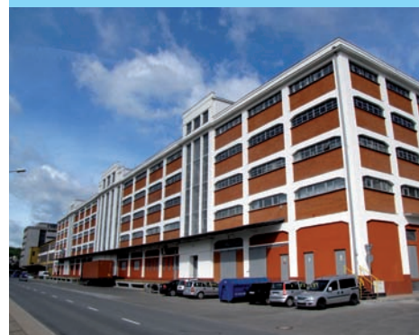
36. Magazyn Długoterminowy „H”, ul. Polska 17 – po przeprowadzeniu prac restauratorskich
