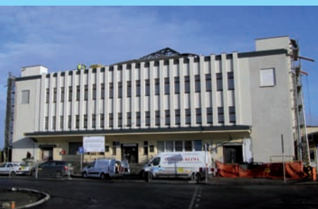
21. Dworzec Morski, ul. Polska 1 – w trakcie odbudowy i adaptacji
