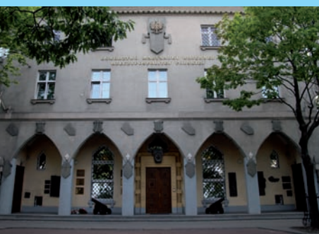
2. Budynek Żeglugi Polskiej, ul. Waszyngtona 44
