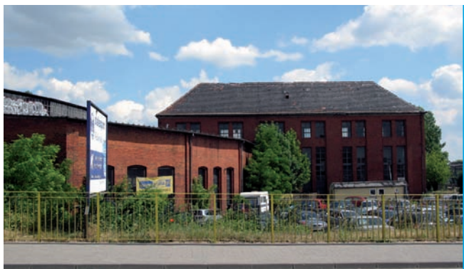
2. Zespół budynków stacji kolejowej w Gnieźnie, 1941-1942, proj.: inż. Rothenpieter (fot. R. Banach, OT NID w Poznaniu, 2014)
