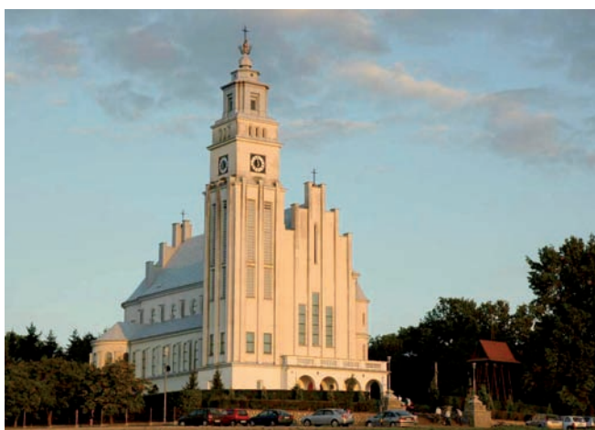
10. Kościół p.w. Nawiedzenia NMP w Medyni Głogowskiej, 1959-1960, proj.: arch. W. Dayczak (fot. B. Potera, OT NID w Rzeszowie, 2014)
