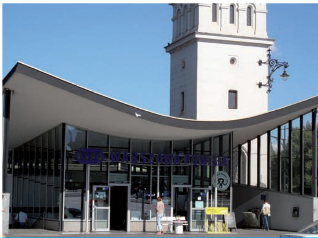
26. Przystanek kolejowy linii średnicowej Powiśle w Warszawie, wiata wejścia od Al. Jeruzolimskich, 1963, proj.: arch. arch. A. Romanowicz, P. Szymaniak (fot. E. Popławska-Bukała, 2014)
