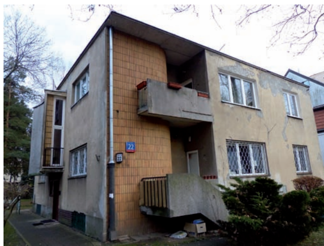
16. Dom wielorodzinny ul. Styki 22, projekt M. Goldberga 1937 r. – brak remontów, widoczne wymiany okien na stolarkę z PCV, ogólne zaniedbanie budynku i otaczającego go terenu (fot. D. Mączyński, 2016)
