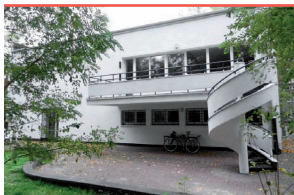
10. Dawna willa Łepkowskich, wymienione okna w elewacji ogrodowej (fot. D. Mączyński, 2016)
