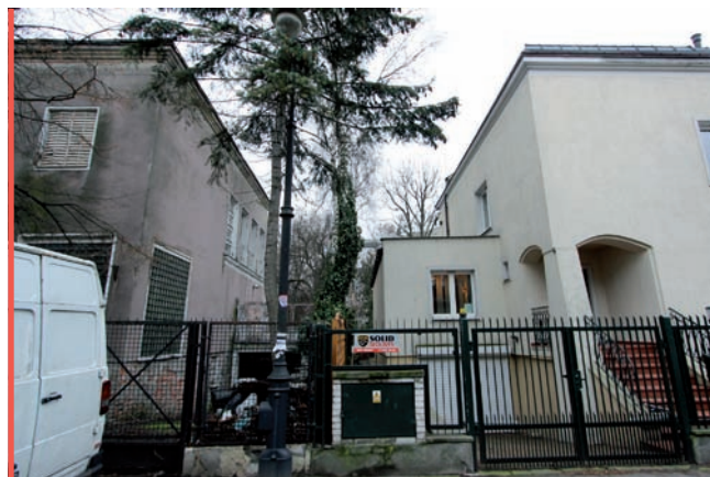
14. Przykład lokalizacji garaży i nadbudowy nad garażem, ul. Czeska (fot. D. Mączyński, 2016)
