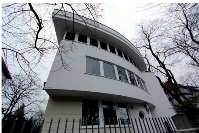
13. ul. Berezynska 22, budynek wybudowany w 2000 r. wg proj. A. Popławskiego i M. Leśniaka (fot. D. Mączyński, 2016)
