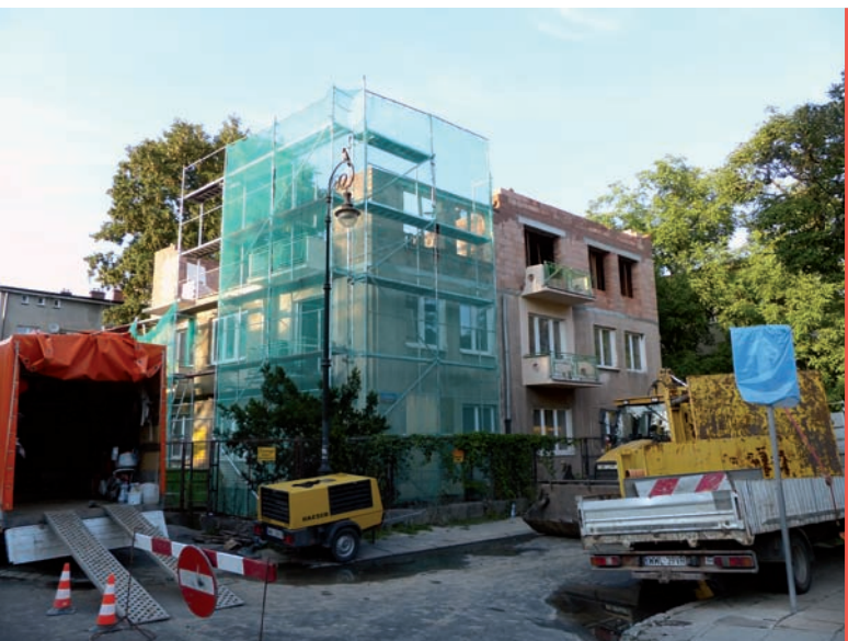
5. Nadbudowa przedwojennego budynku przy ul. Łotewskiej 6 – stan w trakcie prac (fot. D. Mączyński, 2013)
