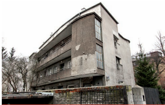
16. Dom wielorodzinny ul. Styki 22, projekt M. Goldberga 1937 r. – brak remontów, widoczne wymiany okien na stolarkę z PCV, ogólne zaniedbanie budynku i otaczającego go terenu (fot. D. Mączyński, 2016)
