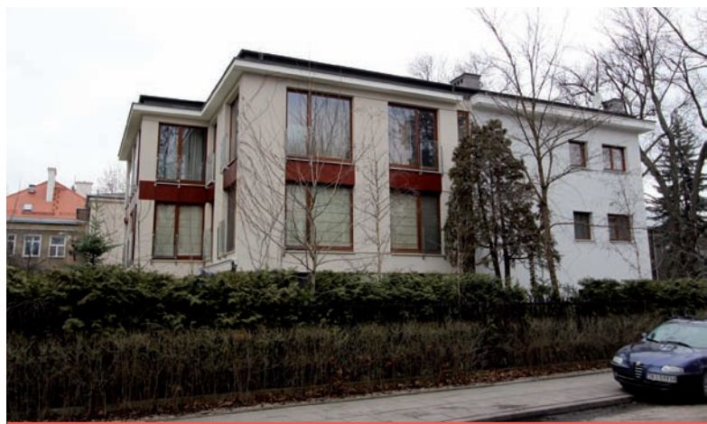
6. ul. Walecznych 10, bardzo znaczna rozbudowa obiektu kosztem terenu ogrodu (fot. D. Mączyński, 2016)
