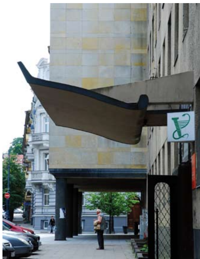
5a. Detal wejścia w skrzydle bocznym (fot. Małgorzata Dolistowska, 2012 r.)
