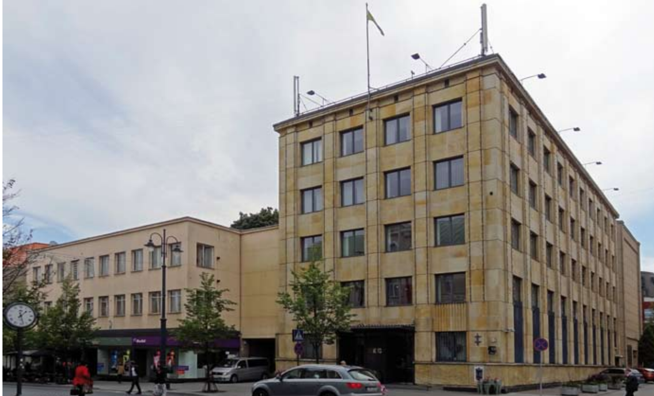
3. Wilno, dawny zespół budynków Polskiej Kasy Oszczędności; na pierwszym planie gmach biurowy, w głębi skrzydło mieszkalne; proj. Juliusz Żórawski i Zbigniew Puget (fot. Małgorzata Dolistowska, 2012 r.)
