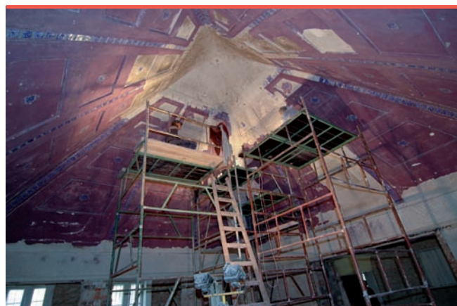
7. Olsztyn, Bet Tahara, Sala Pożegnań, wyburzony wtórny strop, podniebnie kopuły w trakcie prac konserwatorskich, 2007 r. (fot. Jacek Sztorc)
