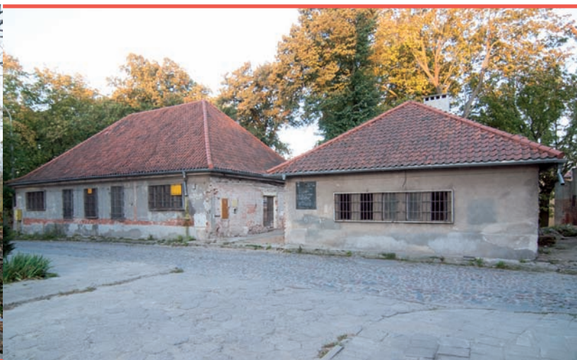
5. Olsztyn, Bet Tahara, stan po wyburzeniu łącznika, 2010 r. (fot. Jacek Sztorc)
