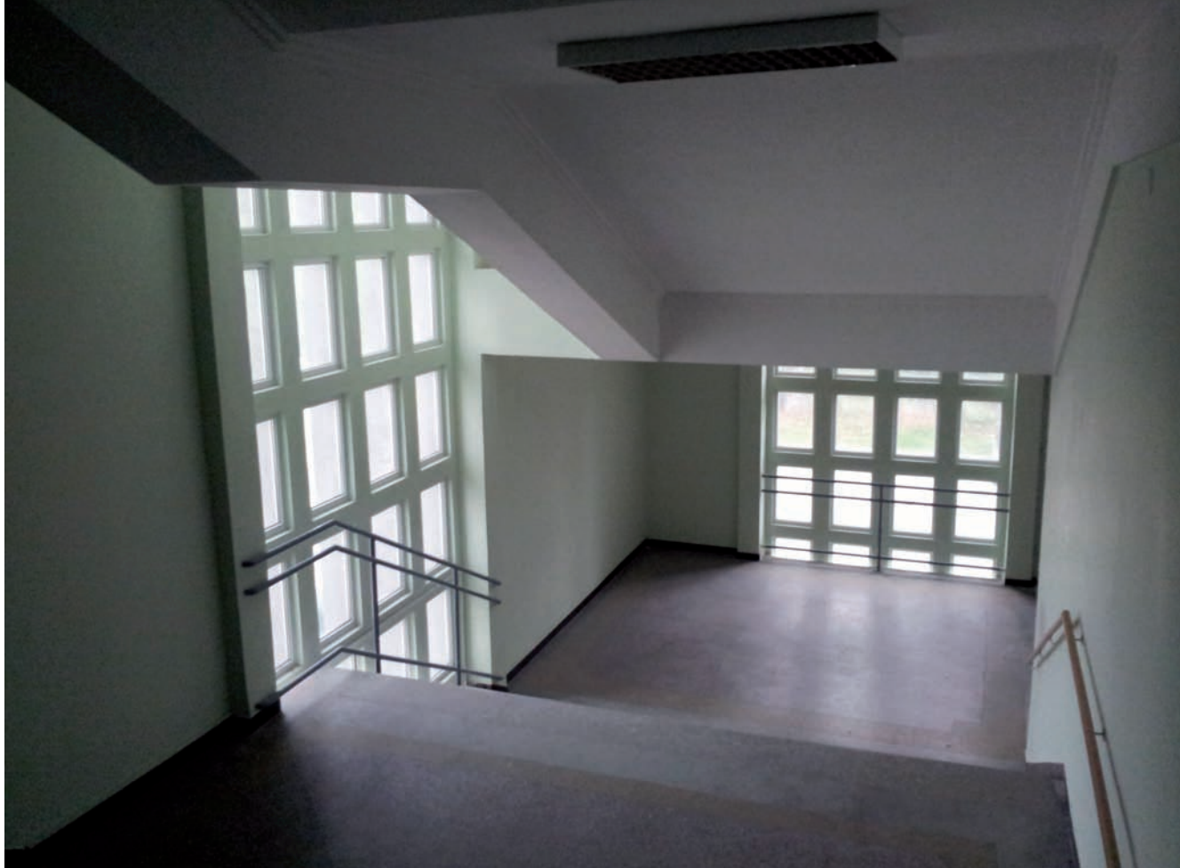
6. Łódź, Wnętrze holu szatniowego Hali Sportowej, ul. Ks. Skorupki 21, arch. Włodzimierz Prochaska, 1957 (fot. A. Sumorok)
