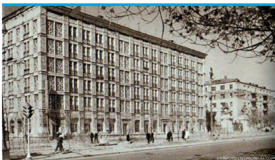
6. Budynek mieszkalny z wielkiej płyty w Alei Leningradzkiej, Moskwa, 1940, architekci A. Burow i B. Błochin oraz inżynierowie A. Kuczerow i G. Karmanow (źródło: ©dkphoto. Досуние фотозарисовки – Советская архитектура столицы, 1917–1955 гг., Sep. 25th, 2010. http://dkphoto.livejournal.com/189248.html )
