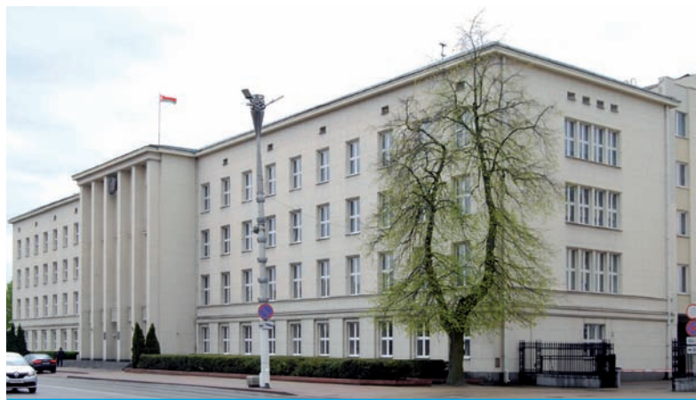
11. Brześć, dawny urząd wojewódzki, 1938, proj. Stanisław Papiewski (fot. J. Lewicki 2017). Przykład monumentalnego budownictwa i jeden z największych budynków użyteczności publicznej wzniesionych na Kresach przed 1939 rokiem
