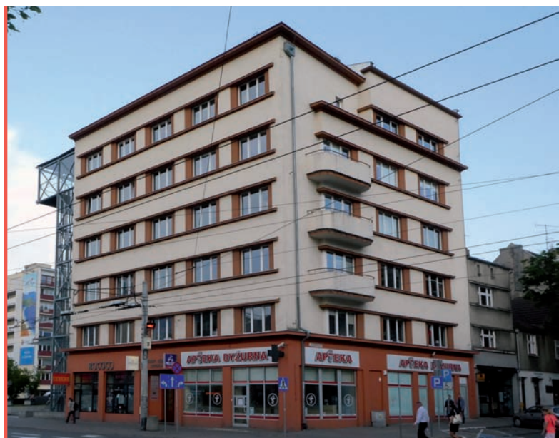
12. Gdynia, kamienica przy ulicy 10 lutego 5, proj. Z. Kupiec, S. Ziółowski, 1934 (fot. J. Lewicki 2016)
