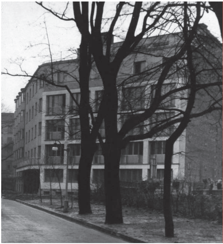
5. Budynek mieszkalny Funduszu Emerytalnego BGK przy ul. Frascati 3, elewacja od strony ul. Konopnickiej, proj. B. Lachert, J. Szanajca, 1936, w głębi dom dochodowy Józefa Handzelewicza przy ul. Frascati 1, proj. J. Gelbard, R. Sigalin, 1934, Archiwum Miasta Stołecznego Warszawy, Akta Nieruchomości
