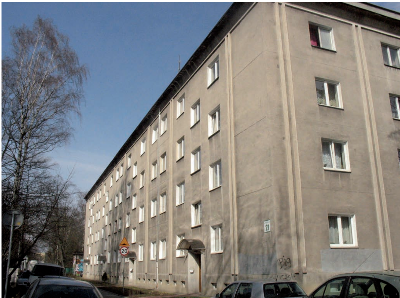
3. Blok przy osiedlu Teatralnym 21 (C-1), zbudowany w 2 połowie lat 50. XX wieku, ( fot. Magdalena Smaga, marzec 2018, wł. Muzeum Krakowa)
