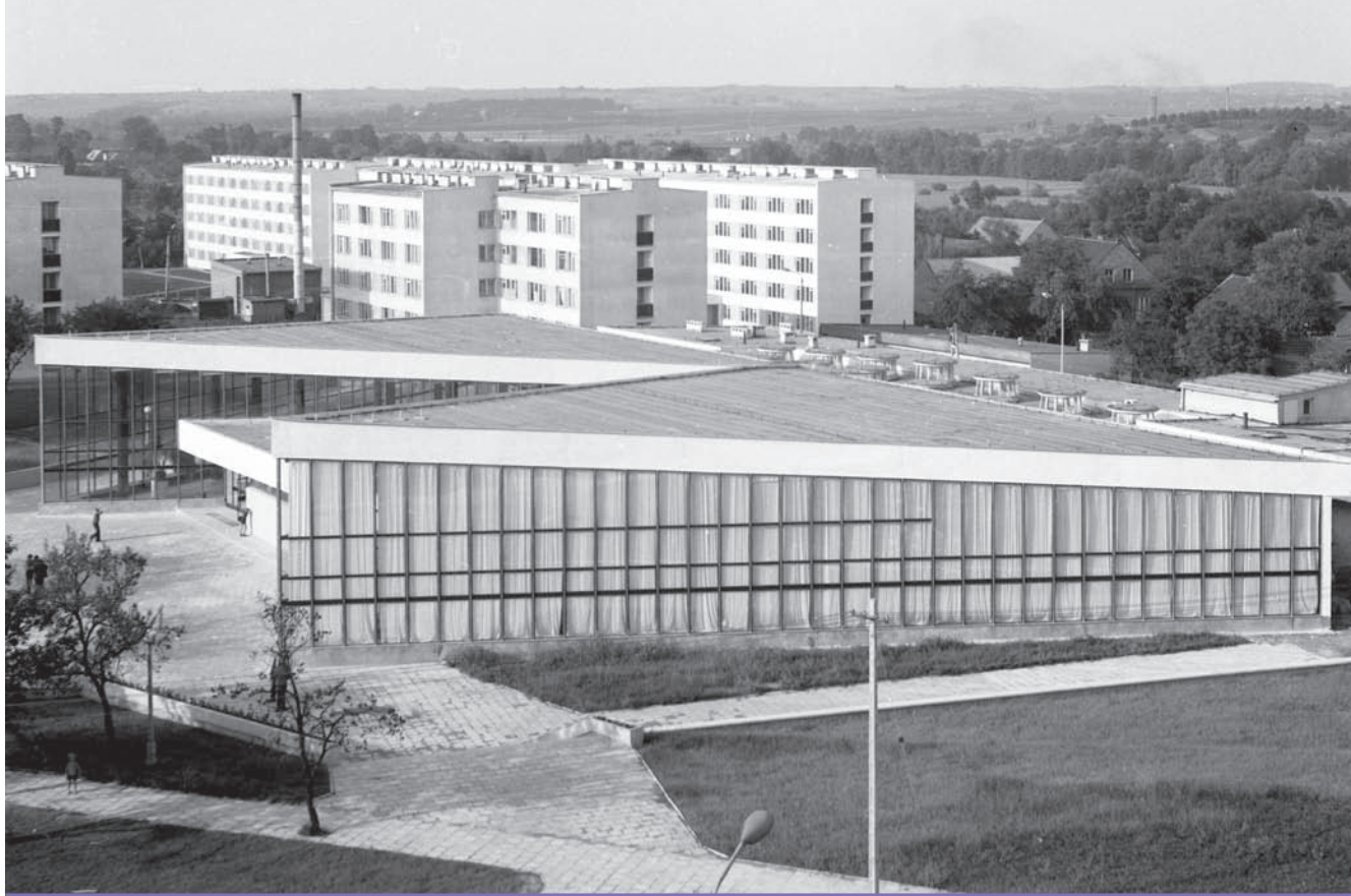
7. Ośrodek handlowo-usługowy „Złota Jesień” w osiedlu Złota Jesień, przy ul. Obrońców Krzyża w Bieńczycach, zbudowany w latach 1966-1969, według projektu Olgierda Krajewskiego (fot. Janusz Podlecki, za: Nowa przestrzeń. Modernizm w Nowej Hucie, red. Kamil Jurewicz, Kraków 2012, fot. s. 50-51)
