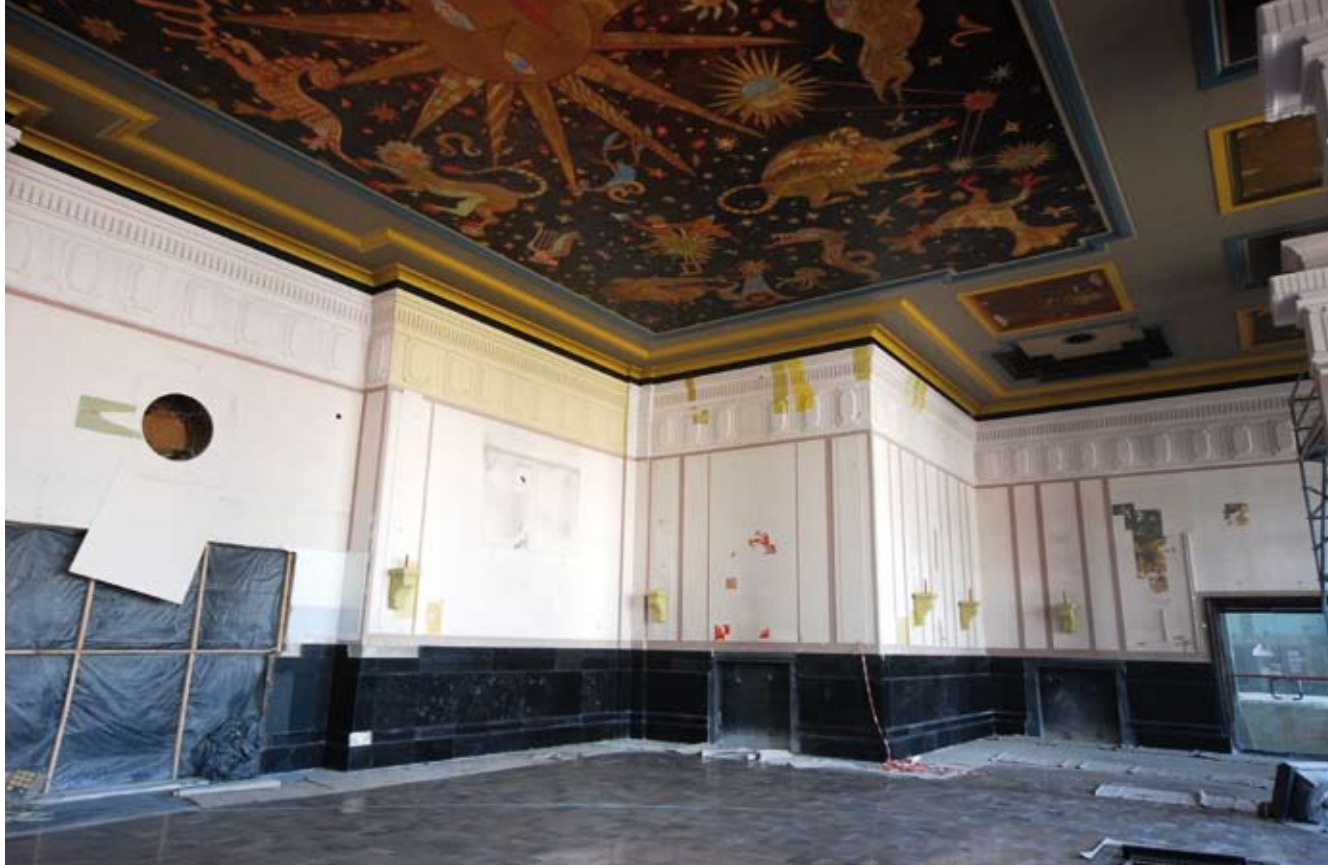
1. Wnętrze sali restauracyjnej przed pracami, odkrywki sondażowe (fot. A. Kriegseisen)
