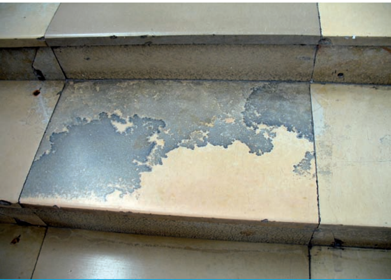
9. Okładzina schodów klatki schodowej Domu Bawelny przy ul. Derdowskiego 7 wykonana z mikrytowej odmiany wapienia zbitego Solenhofen (Solnhofner). Widoczne, charakterystyczne dla tego kamienia dendryty w formie niebiesko-fioletowych plam (fot. Ewa Jachnicka).
