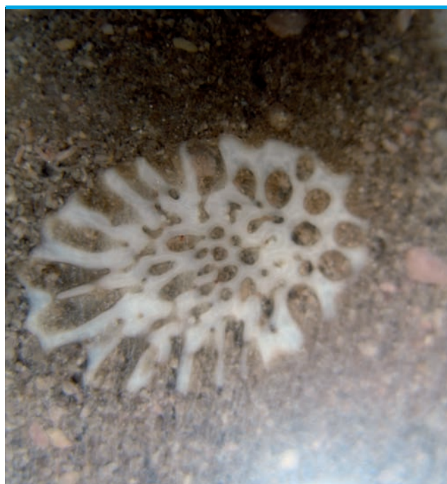
6. Fragment wapiennej balustrady sieni Banku Rolnego przy ul. Wójta Radtkego 53 z zachowanymi szczątkami organicznymi wtopionymi w strukturę kamienia (fot. Ewa Jachnicka)
