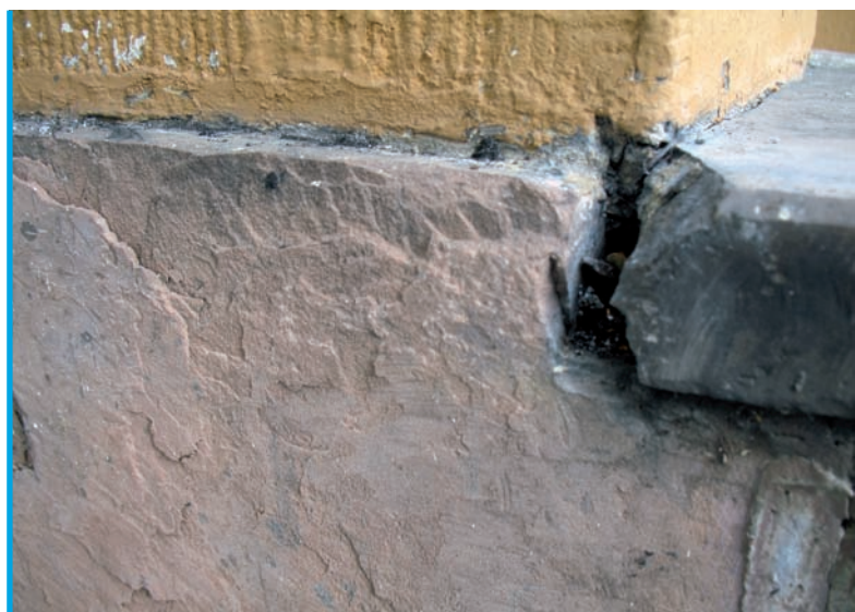
3. Fragment okładziny stopni zewnętrznych wykonanych z piaskowca Suchedniów-Włochy prowadzących do wejścia głównego Domu Bawelny przy ul. Derdowskiego 7 (fot. Ewa Jachnicka)
