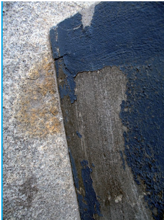
5. Cokoły filarów wykonane z czarnego marmuru importowanego współcześnie pomalowane niebieską farbą. Wejście do budynku dawnego Urzędu Celnego, ul. Rotterdamska 9 (fot. Ewa Jachnicka)
