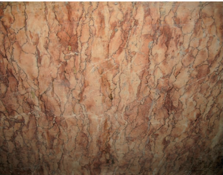
11. Marmurowa, importowana płyta okładziny ściennej sieni dawnego gmachu Dowództwa Floty przy Rondzie Bitwy pod Oliwą 1 (fot. Ewa Jachnicka)
