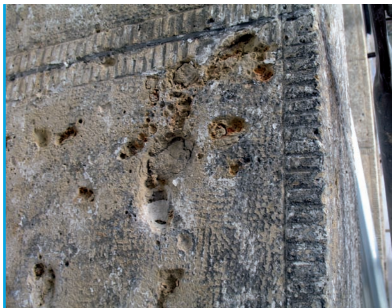
10. Fragment dekoracji elewacyjnej dawnej siedziby Banku Gospodarstwa Krajowego przy ul. 10 Lutego 8, wykonanej z wapienia mikrytowego, mylonego z piaskowcem. (fot. Ewa Jachnicka)
