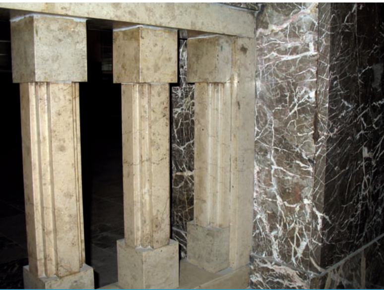
4. Balustrada reprezentacyjnych schodów Banku Polskiego na rogu ul. 3 Maja i 10 Lutego wykonana z wapieni kieleckich. (fot. Ewa Jachnicka)
