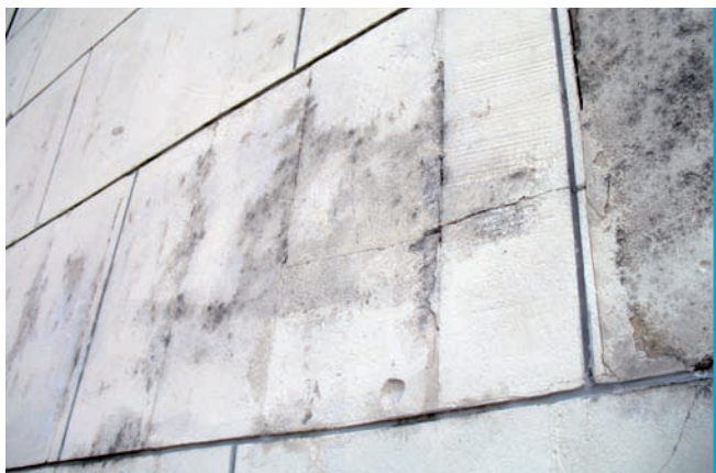
1. Okładzina z wapienia pińczowskiego istniejąca na elewacji dawnej siedziby Zakładu Ubezpieczeń Społecznych, przy ul. 10 Lutego 24 (fot. Ewa Jachnicka)
