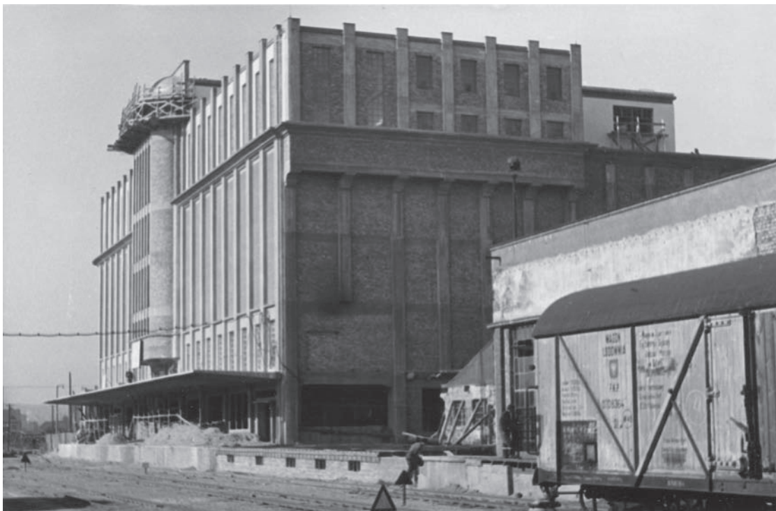
5. Gdynia, Nabrzeże Angielskie, Chłodnia nr 1 w 1949 r., wzniesiona w latach 1948-1950 na miejscu międzywojennej Hali i ocalałego ze zniszczeń fragmentu Chłodni Rybnej, widocznego w tylnej części obiektu. Na zdjęciu budynek przed otynkowaniem (źródło: Muzeum Miasta Gdyni)
