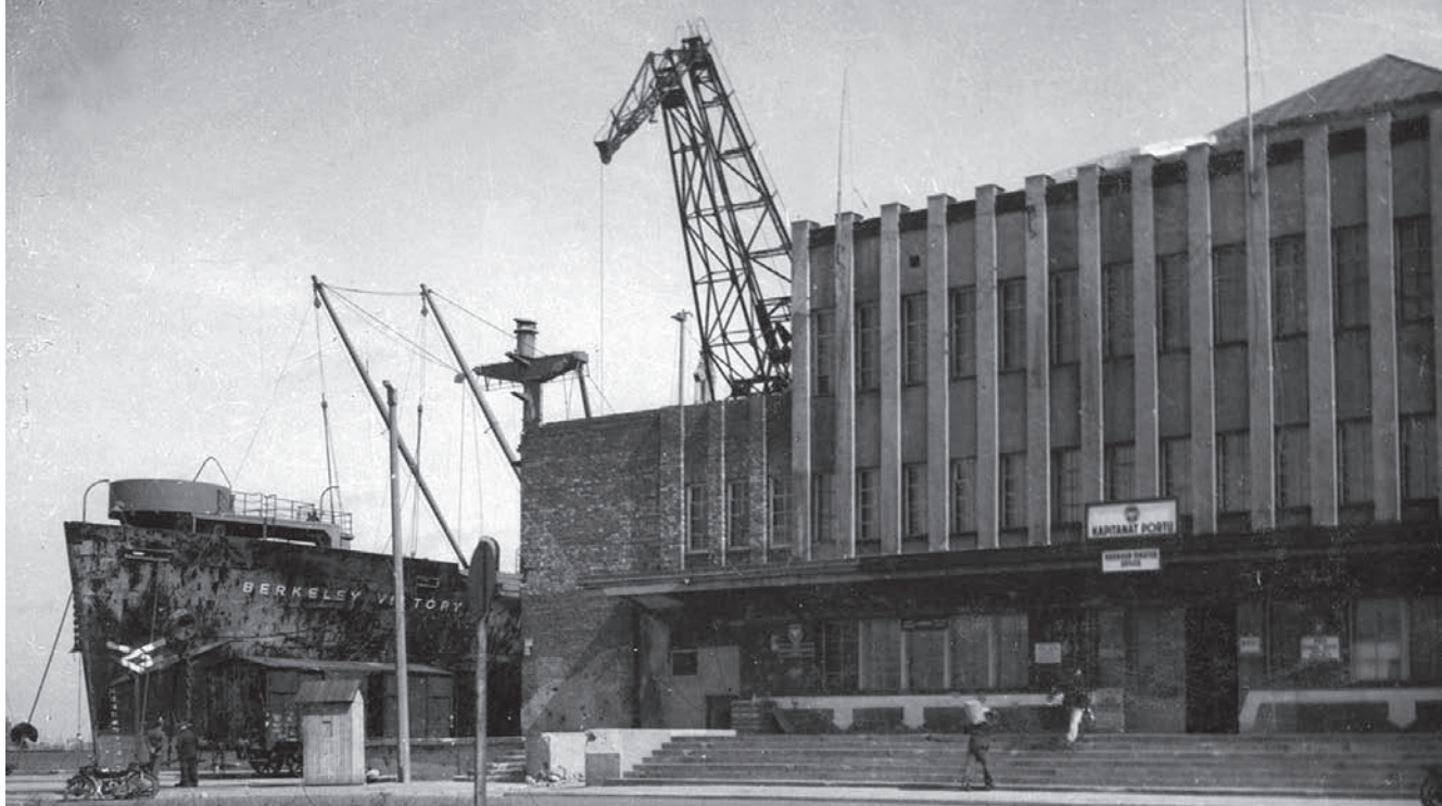
3. Gdynia, ul. Polska 1, Dworzec Morski w 1946 r. Widoczny w północno-zachodnim narożniku budynku ubytek powstał w wyniku alianckiego nalotu z 1943 r. i został odbudowany dopiero w latach 2013-2015 w trakcie kompleksowej adaptacji obiektu na Muzeum Emigracji. Po wojnie do 1963 r. w Dworcu Morskim mieścił się Kapitanat Portu (źródło: Muzeum Miasta Gdyni, fot. Jan Bulhak)
