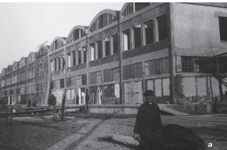
4. Gdynia, ul. Polska 1, elewacja Południowa Dworca Morskiego w 1945 r.: a. widoczne przekształcenia oryginalnego układu w formie wykonanych przez Niemców podczas okupacji otworów okiennych; b. widoczny ciąg zamurowanych w trakcie remontu okien i pozostawionych w ich miejscu blend, które zostały zlikwidowane w 2015 r. podczas adaptacji obiektu na Muzeum Emigracji (źródło: Archiwum Pań-stwowe w Gdańsku Oddział w Gdyni, fot. W. Glasko)
