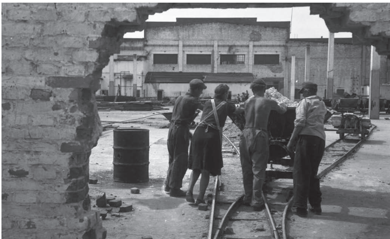
2. Gdynia, rozbiórka zniszczonego magazynu firmy „Cukroport III/IV” przy nabrzeżu Polskim w 1946 r. Przez widoczną dużej wielkości wyrwę w murze magazynu widać elewację magazynu „Cukroport I/II”. Prace przebiegają przy wykorzystaniu tymczasowo położonych szyn (źródło: Archiwum Państwowe w Gdańsku Oddział w Gdyni)
