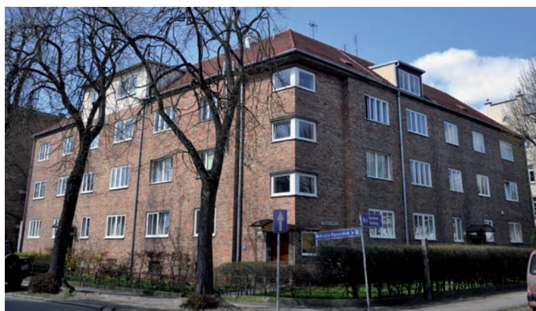
6. Multi-family house, Książąt Pomorskich 12-14, Kazimierza Wielkiego 9, Sopot, architects: E. Wronka & O. Kempe, 1932 Photo by A. Narczewska
