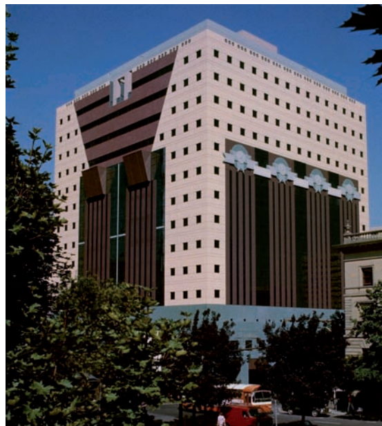
12. Budynki Usług Rządowych, Portland, w stanie Oregon zaprojektowane przez Michaela Graves'a, ukończone w 1982 roku. Zespół niedawno został uznany za zabytek i umieszczony w Federalnym Rejestrze Zabytków (fot. Steve Morgan, Creative Commons)
