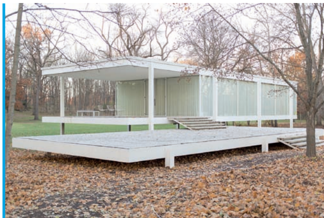
3. Farnsworth House, Plano, Illinois. Ludwig Mies van der Rohe zaprojektował ten dom weekendowy dla dr Edith Farnsworth już na początku 1945 roku, ale budowa rozpoczęła się dopiero w roku 1951. Dom ucierpiał w kilku powodziach. Obecnie trwają prace nad jego zabezpieczeniem. Dom jest otwarty dla zwiedzających (fot. Victor Grigas, Creative Commons)
