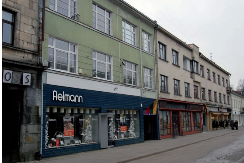
10. Budynki przy alei Laisvės 83 i 85 w Kownie, proj. Mozė I. Bloch, Isaak Trakman, koniec lat 30. XX w. (fot. V. Petrušis, 2013)
