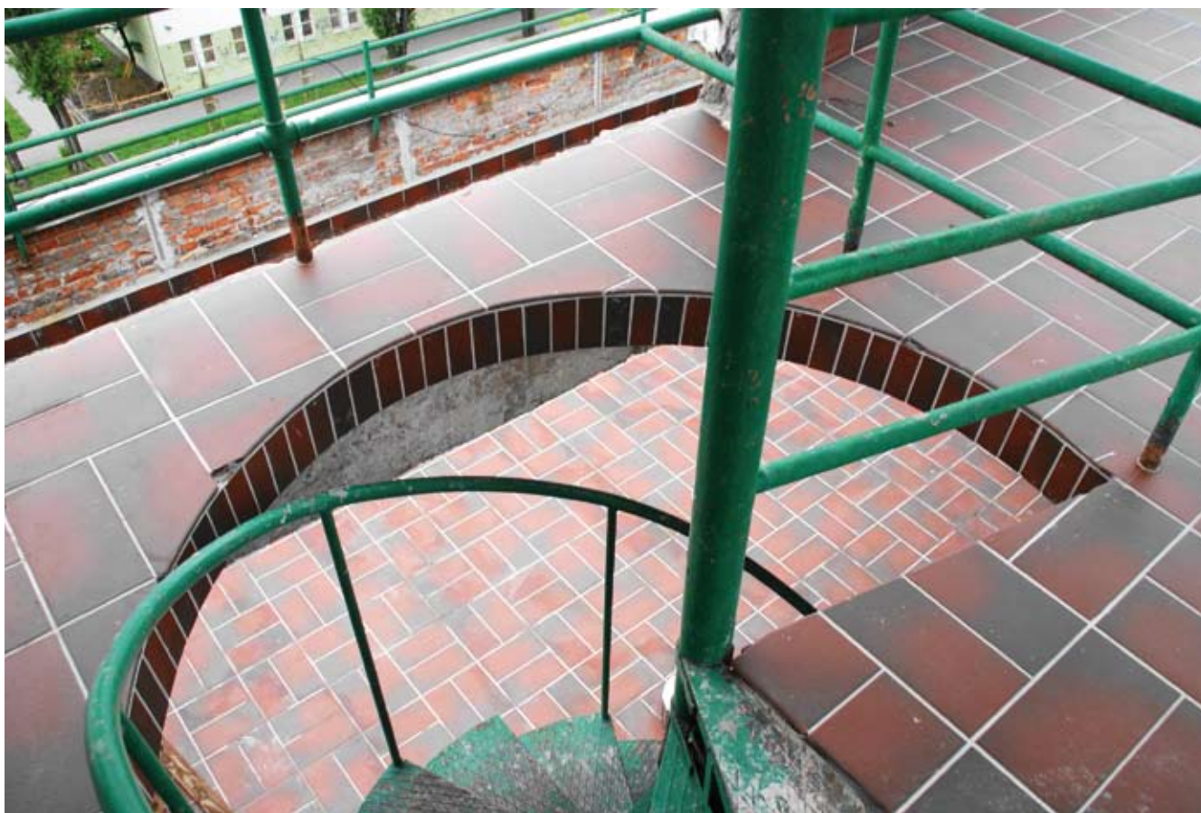
9. Schody na tarasie po remoncie (fot. Irena i Andrzej Olszewscy)
