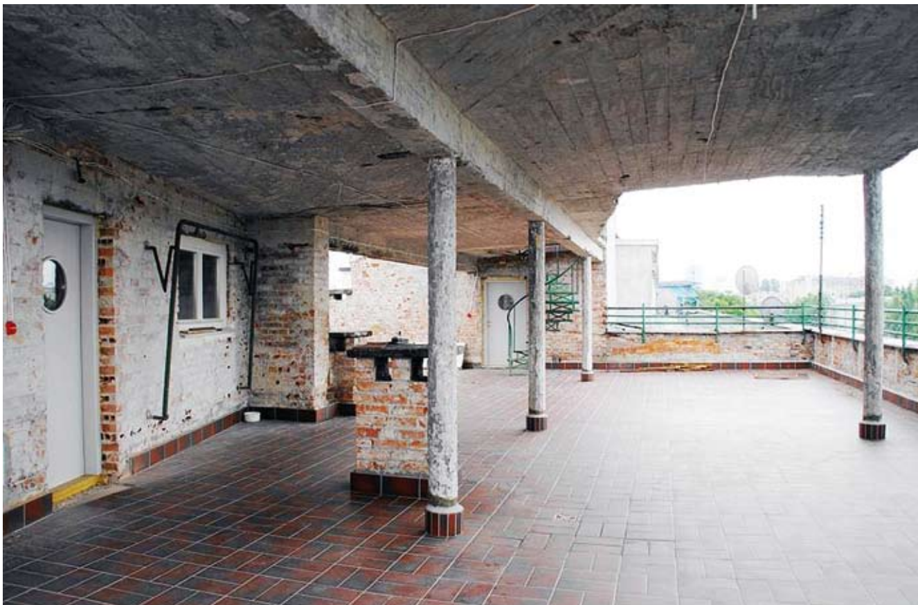
4. Taras w trakcie remontu 2012 r. (fot. Irena i Andrzej Olszewscy)
