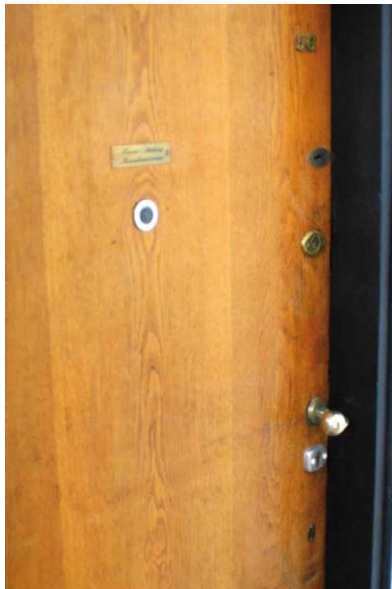
7. Drzwi po remoncie (fot. Irena i Andrzej Olszewscy)
