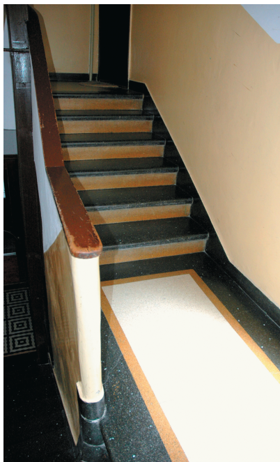
Schody wykonane z wyprawy lastrykowej
