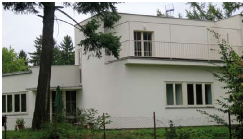
5. Dom proj. Ludwiga Moshamera, widok od ogrodu (pd-zach.), stan renowacji w ramach programu miejskiego, 2013 (fot. J. Urbanik)
