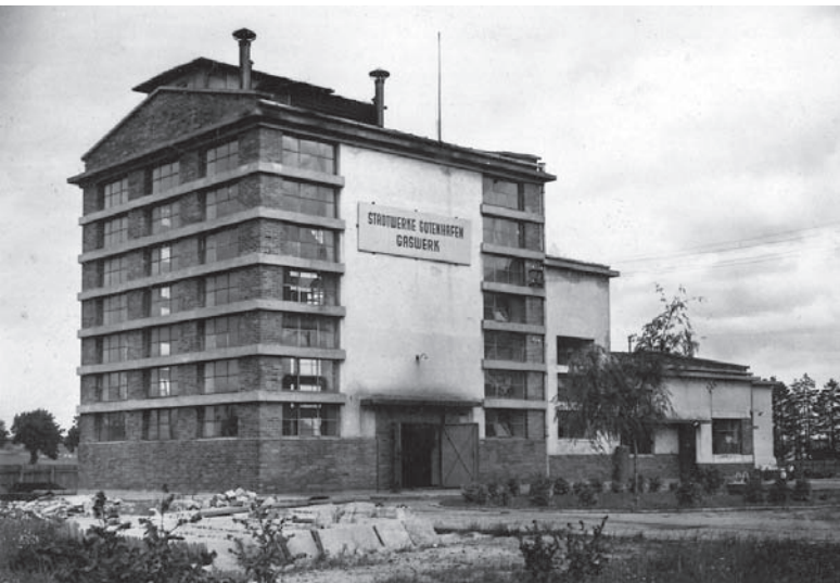
11. Gdynia, ul. Chyłońska 110, hala generatorów Zakładu Gazowego w Gdyni (nieistniejąca) w 1940 r., proj. Jerzy Müller, 1931 r. (źródło: APG O/G nr 90/1431)
